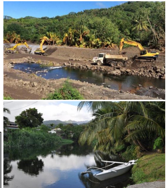
Contraste entre le lit recalibré de la rivière Taharuu à Papara (photo du haut) et encore naturel de la rivière Tuauru à Mahina (en bas)
