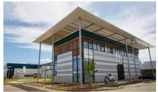
Stations d'épuration de Papeete et de Punaauia
