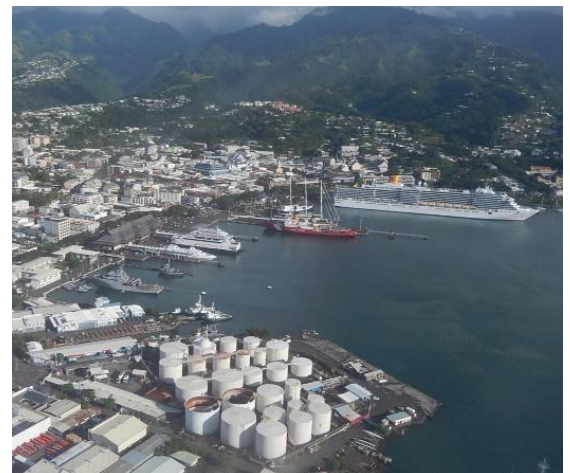
Cuves de carburant actuellement stockées à Fare Ute
