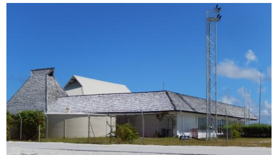
Cuve de stockage des eaux de pluie installée dans l'aérogare de Rangiroa
