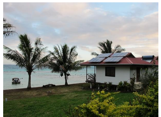
Maison équipée de panneaux solaires aux Gambier
