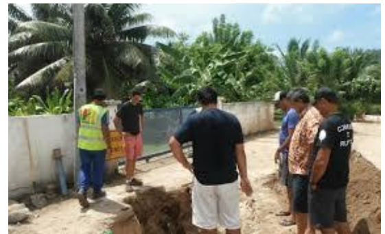
Travaux de rénovation du réseau d'eau potable
