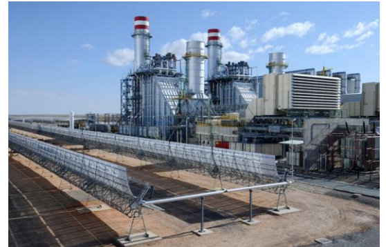
Exemple de centrale hybride thermique-solaire (Ain Beni Mathar, Maroc)
