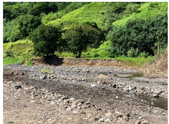
Figure 31 : Photo P16 - La berge gauche à l'entrée de la plaine alluviale s'est affaissée sous l'effet de la crue.
