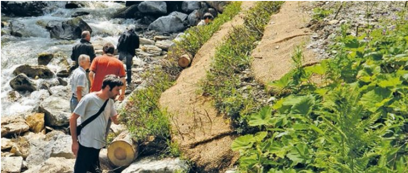
Figure 79 : Végétalisation d'un enrochement à partir d'un support en géotextile naturel. (tiré de Evette et al. , 2015)
