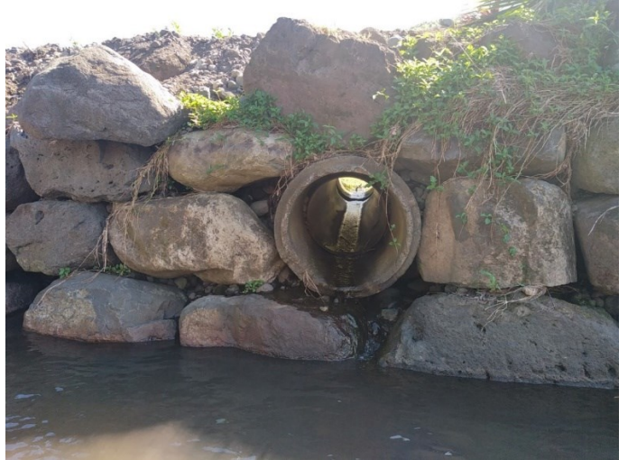
Figure 26 : Photo P10, buse servant d'exutoire vers la rivière pour un petit ruisseau prenant sa source dans des résurgences sur la rive droite.
