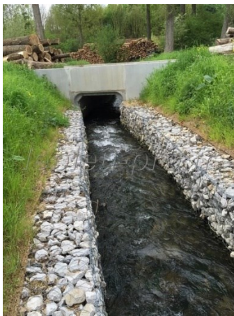
Figure 73 : Canalisation d'un cours d'eau par des gabions (© lebleu-pro.fr)
