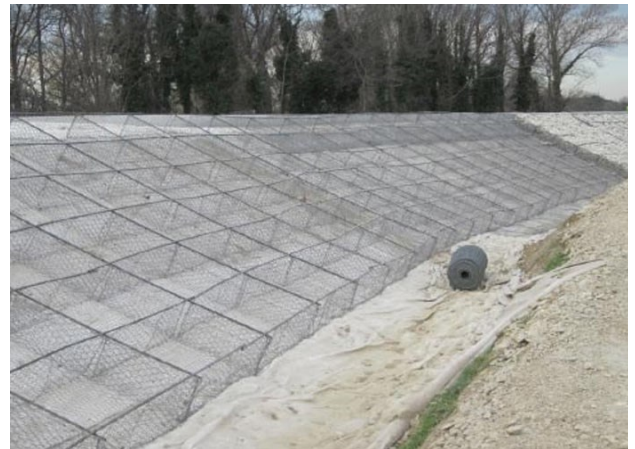
Figure 77 : Protection de berge en matelas Renos (© Maccaferri.com)
