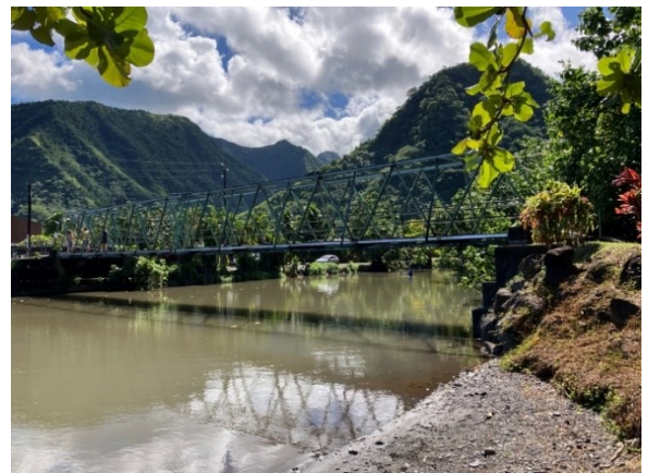
Figure 18 : Photo P2, passerelle vue depuis l'embouchure.
