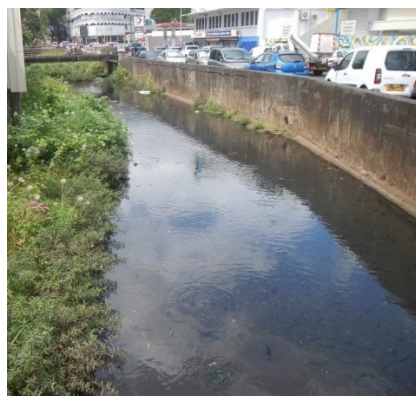
Figure 71 : Canalisation de la rivière Papeava dans le centre-ville de Papeete.
