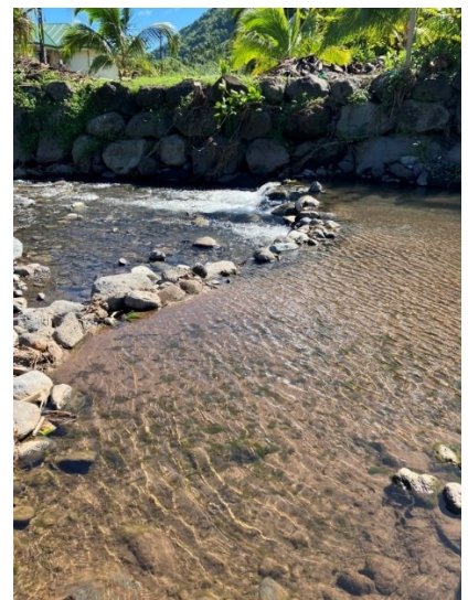
Figure 28 : Photo P12, vue du gué qui est consolidé par un seuil artificiel constitué d'un pavage de gros blocs métrique.
