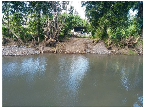
Figure 20 : Photo P4, affaissement localisé de la berge gauche au cœur de la section de Purau.
