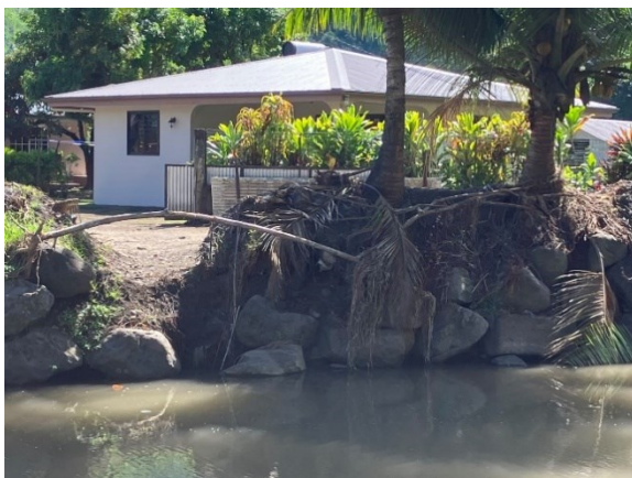
Figure 23 : Photo P7, la berge droite a été ouverte à la fin de la crue pour permettre à l'eau qui avait envahi les habitations de s'évacuer.
