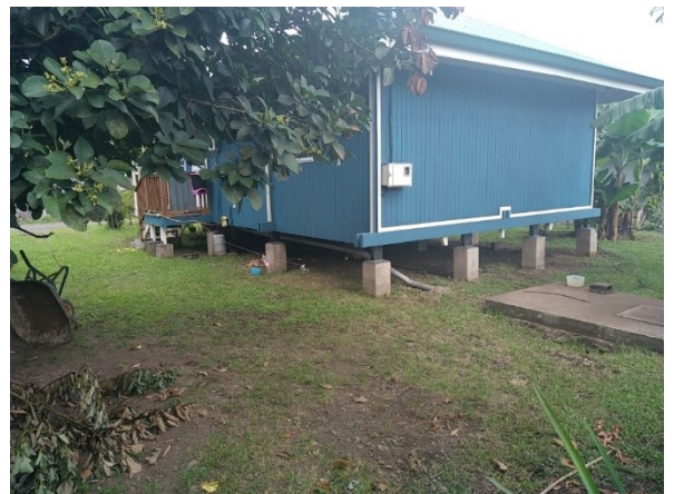
Figure 50 : Fare OPH en Rive droite, surélevé à 120 cm au-dessus du sol.
