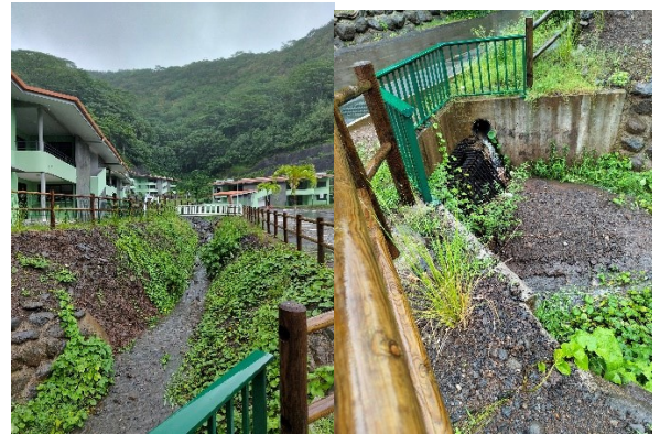
Figure 27 : Canal d'évacuation et exutoire de l'affluent 3.
