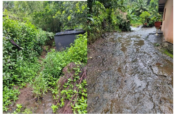
Figure 26 : L'affluent 1 finit sa course par-dessus une petite servitude bétonnée.
