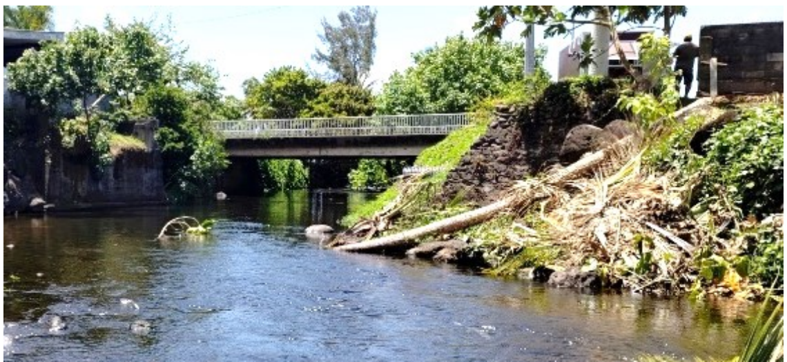
Figure 31 : Vu du pont 1 depuis l'amont.
