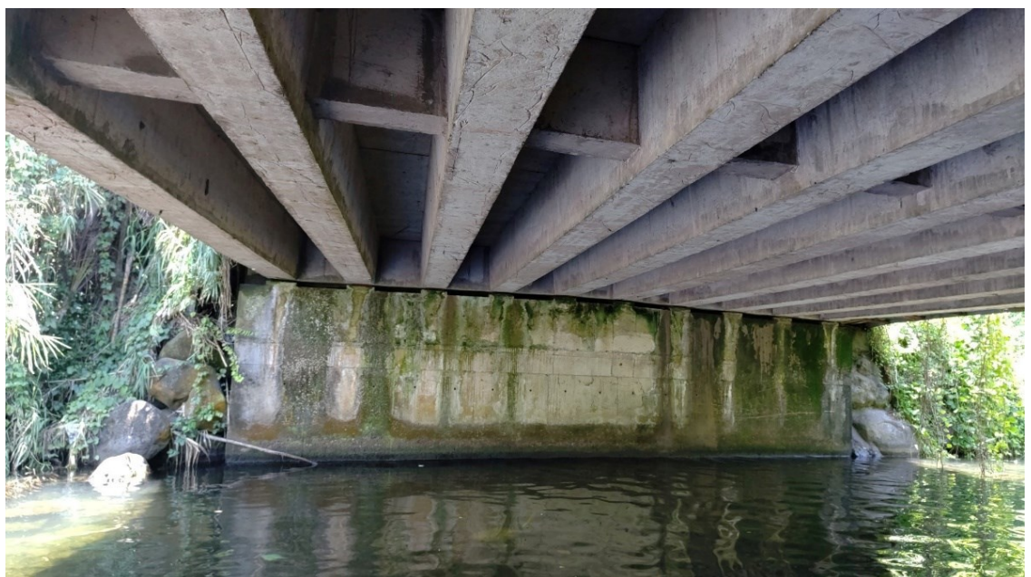
Figure 32 : Observation sous le tablier du pont P1.
