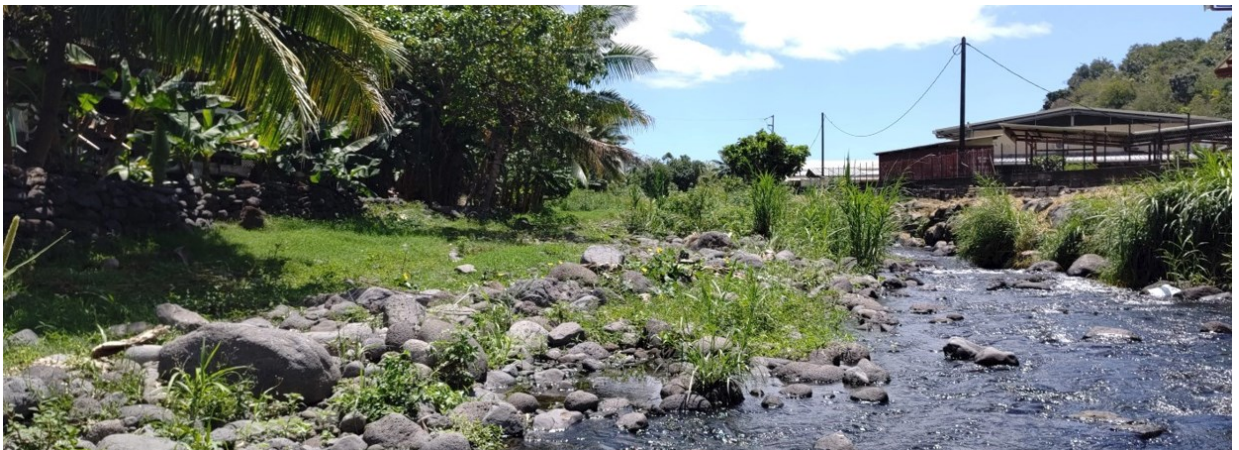
Figure 33 : La berge droite est la berge concave dans le coude de la rivière. C'est un point de débordement assez marqué.
