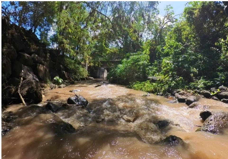
Figure 33 : Ouvrage traversant O15 vu depuis l'amont.
