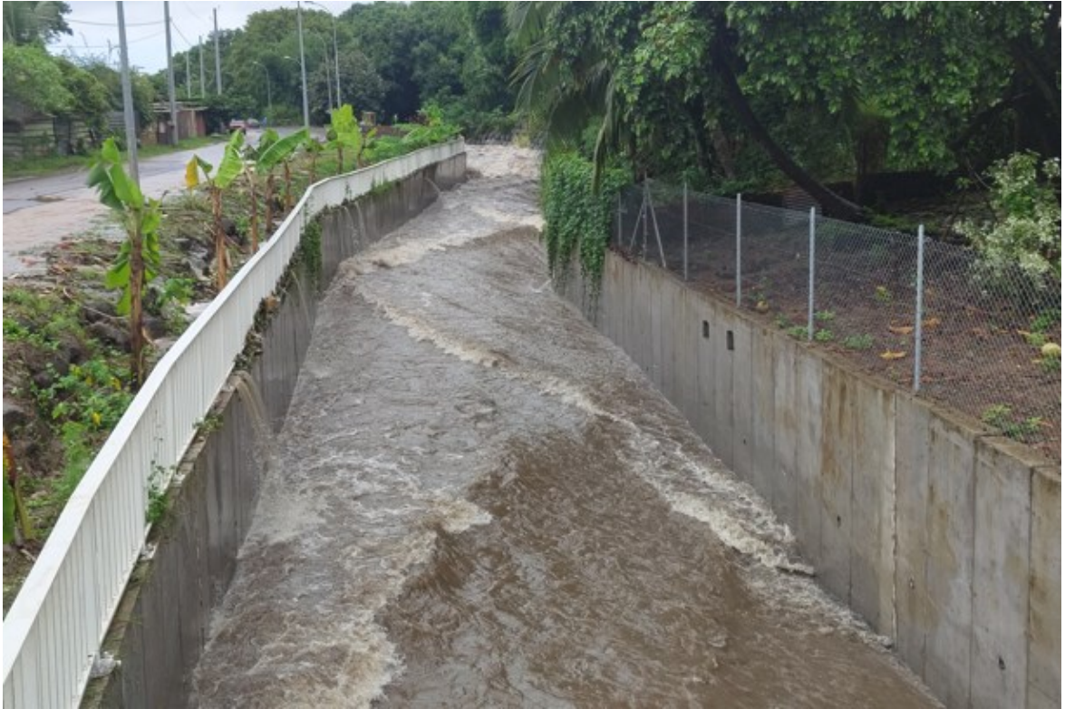
Figure 49 : Dynamique d'écoulement dans le canal bétonné lors d'une crue dans la rivière Nahoata.
