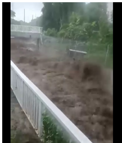
Figure 48 : Débordement observé sur la portion du lit à l'aval de l'hippodrome le 12 février 2024. La photo a été prise 2h après le pic de la crue.
