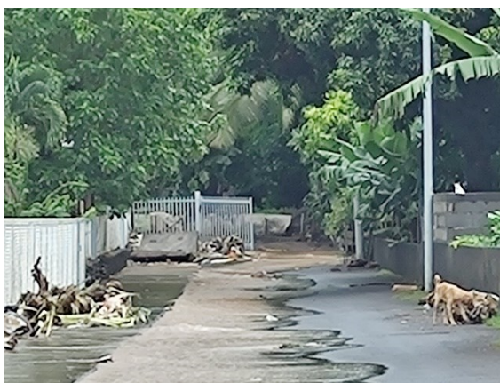
Figure 24 : Débordement du lit canalisé de l'affluent 5 sur la servitude longeant le cimetière.
