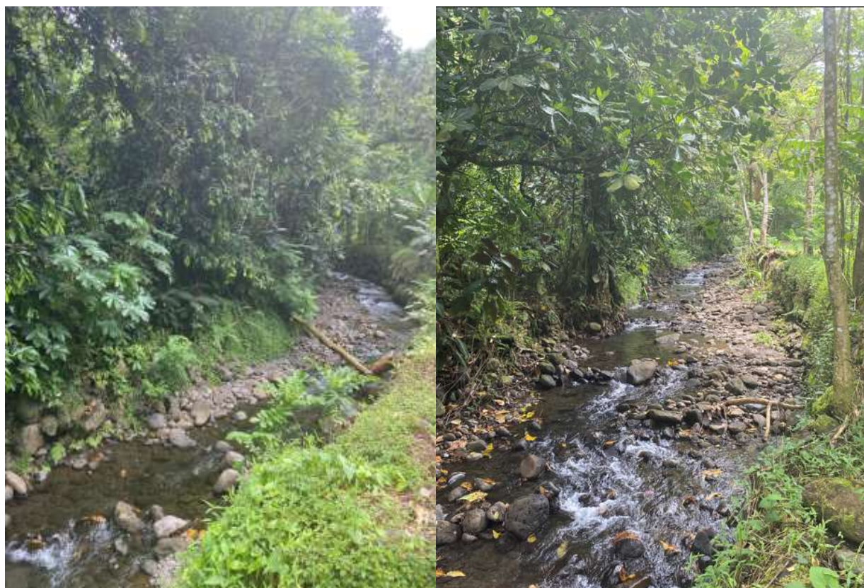
FIGURE 8 : ENCAISSEMENT DE LA RIVIERE ET ATERRISSEMENTS
