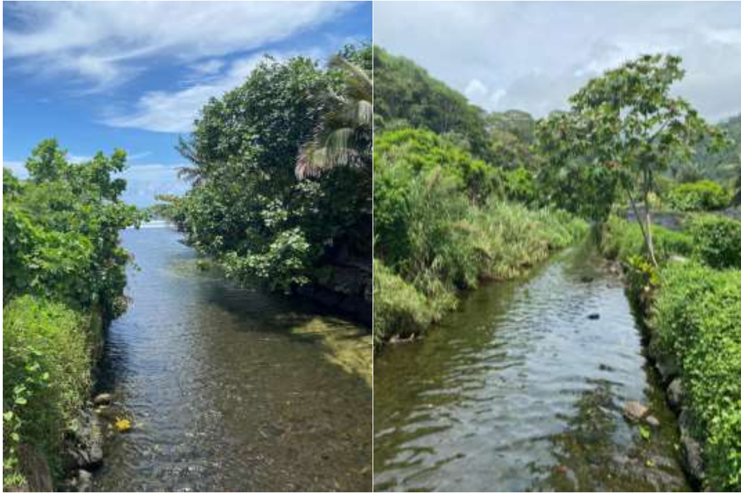
FIGURE 3 : TRAVERSEE DE LA ROUTE TERRITORIALE (GAUCHE : VUE AVAL – DROITE : VUE AMONT)
