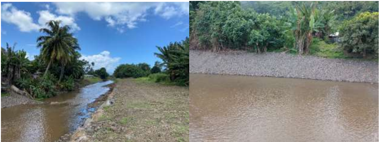
FIGURE 5 : ENROCHEMENTS DES BERGES
