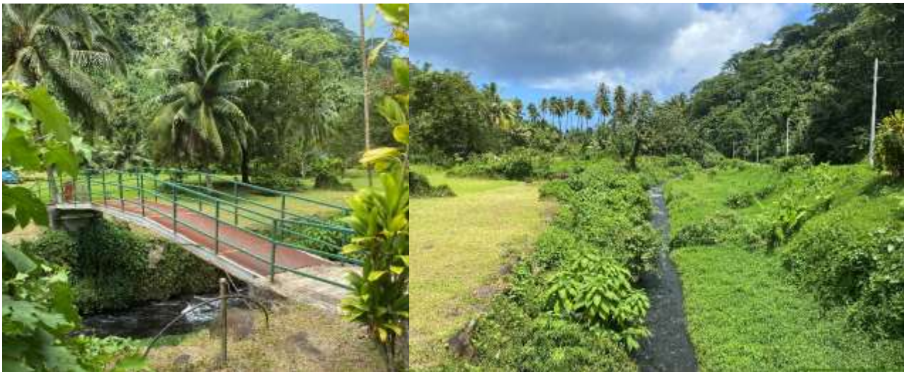
FIGURE 8 : PASSERELLE ET VUE AVAL
