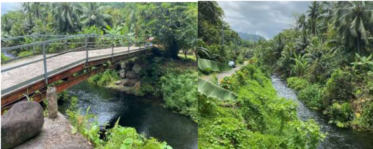
FIGURE 6 : PASSERELLE ET VUE AMONT
