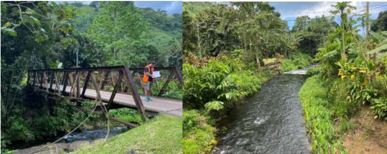
FIGURE 7 : PASSERELLE ET VUE AVAL
