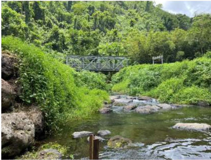
FIGURE 9 : DERNIER OBSTACLE IDENTIFIE A L'AMONT
