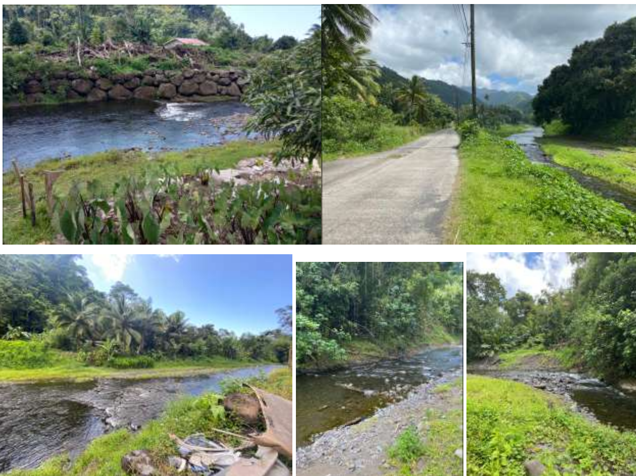
FIGURE 8 : ALTERNANCE DE PETITS SEUILS SUR LA PARTIE AMONT DE LA VAIRAHARAH
