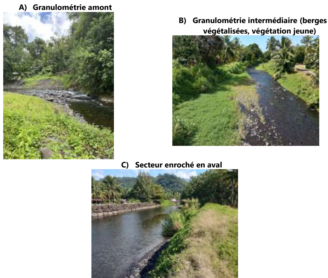
FIGURE 15 : GRADIENT GRANULOMETRIQUE AMONT - AVAL DU COURS D'EAU ET LOCALISATION DES ENROCHEMENTS / PROTECTIONS DE BERGES
