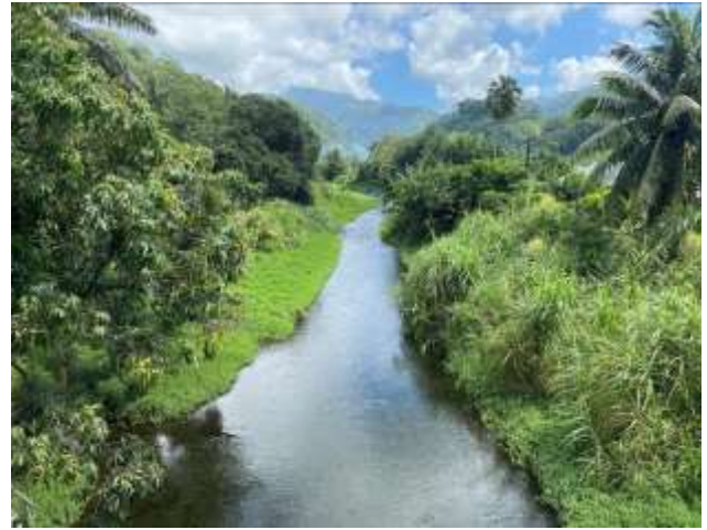
FIGURE 6 : AMONT DU PONT FRANCHISSANT LA RT
