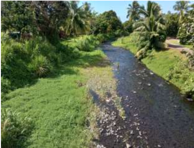
FIGURE 5 : AVAL DU PONT FRANCHISSANT LA RT
