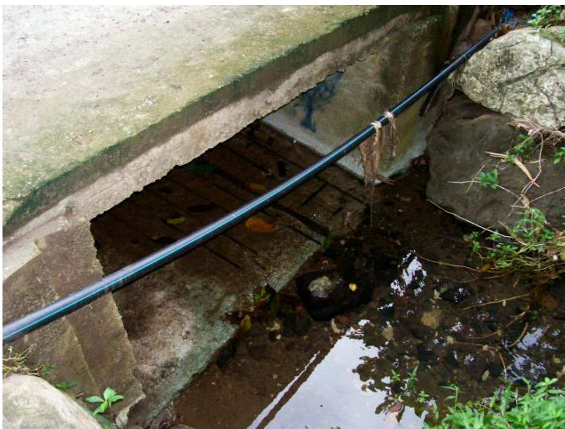
Pont-cadre aval sur l'affluent de la rivière de Faie (photo prise en juin 2006)
