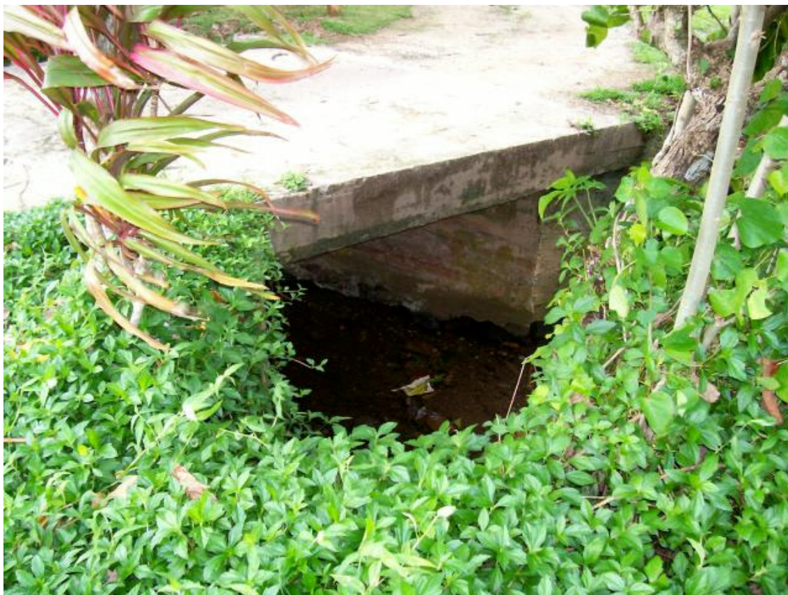
Pont-cadre amont sur l'affluent de la rivière de Faie (photo prise en juin 2006)
