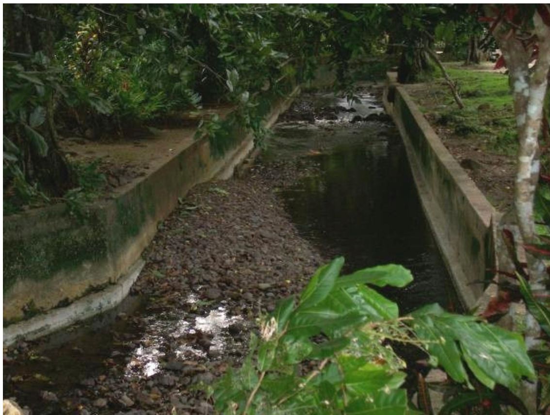
Amont du cours d'eau de Faie : lit canalisé et bétonné (photo prise en juin 2006)
