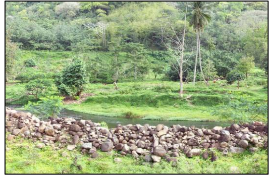
Merlon digue à l'amont du cône
