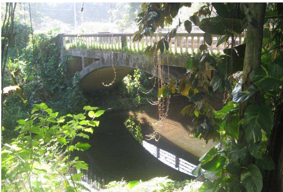
Photographie n°3 : Pont limitant de la route de ceinture (source EGIS Eau)
