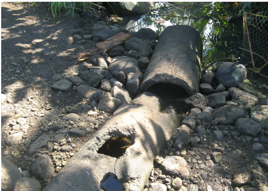
Photographie n°7 : Buses d'alimentation et de vidange de l'ancien méandre (source EGIS Eau)
