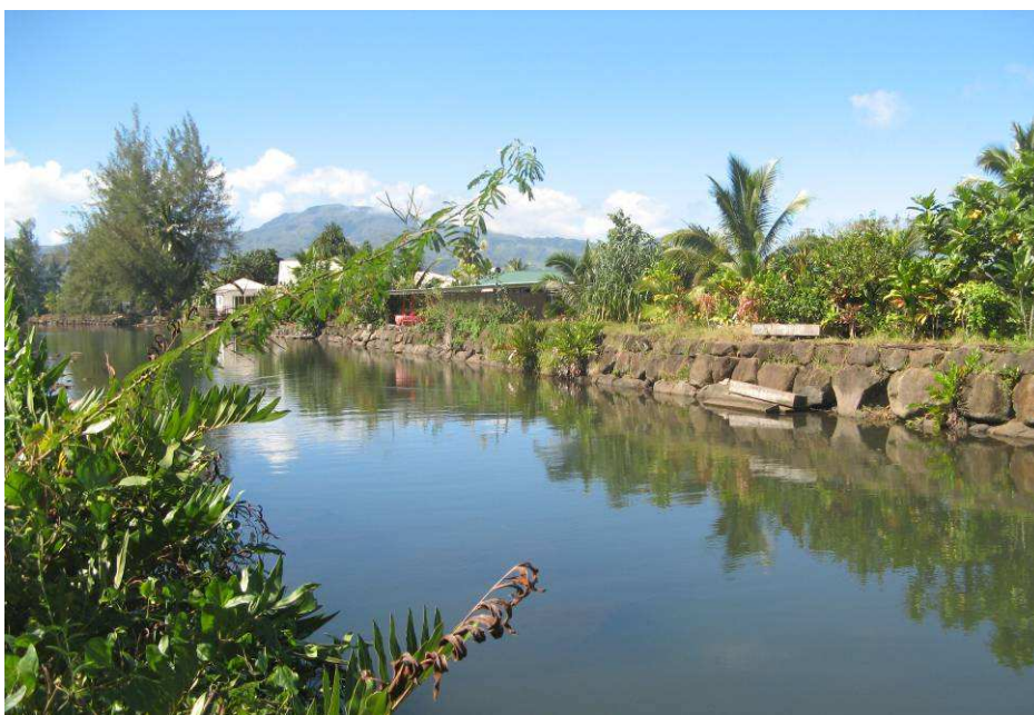
Photographie n°5 : Endiguement des berges en aval de la route de ceinture (source EGIS Eau)
