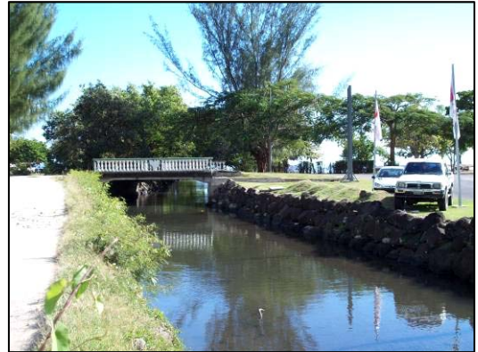
Le pont sur la Maharepa vue depuis l'amont
