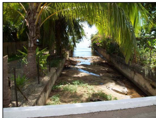
Débouché littoral d'un drain secondaire
