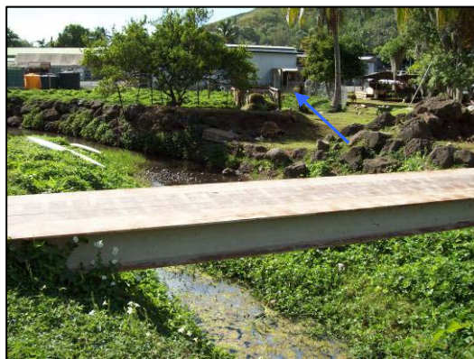
Point de sortie au niveau de la brèche
