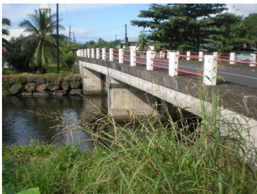
Photo1 : Franchissement de la RT
