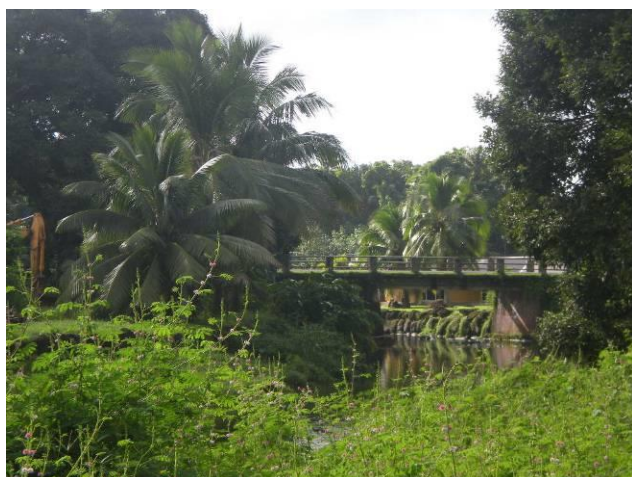
Photo1 : Franchissement de la RT : vue amont
