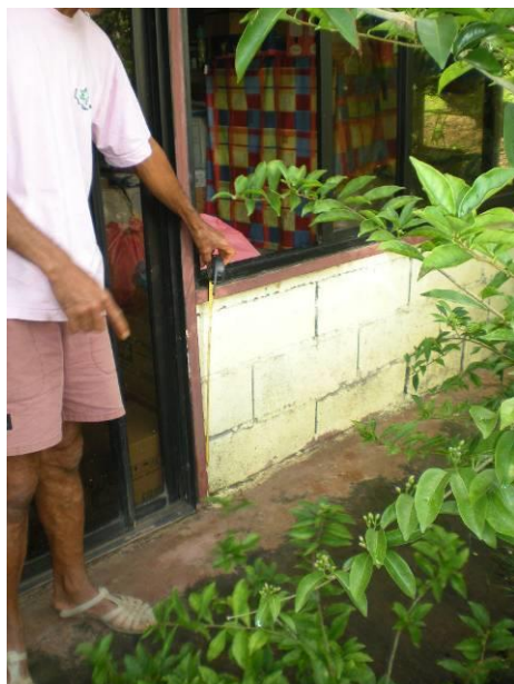
Photo 3 : PHE aval RT_ Maison Tiapari
