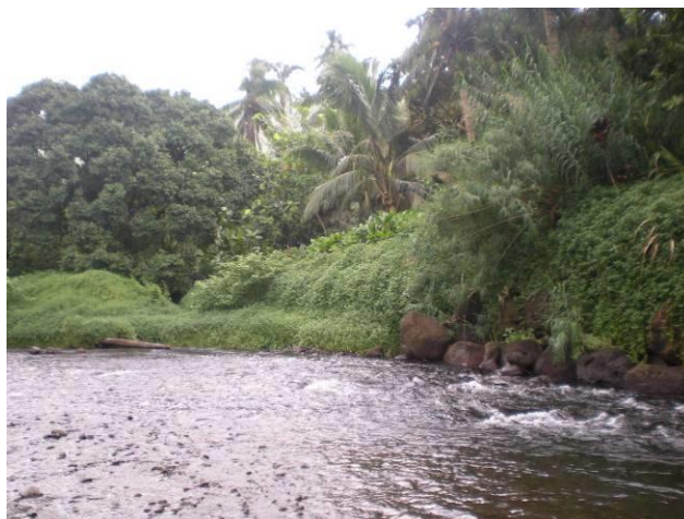
Photo 7 : Coude en partie protégé
