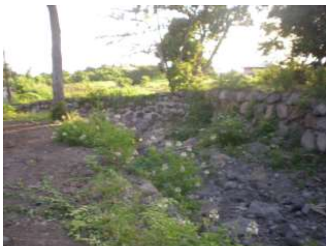
Photo 9 : Vue amont franchissement
