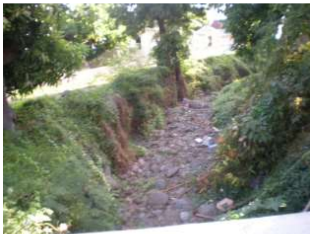
Photo 3 : Vue aval pont RT
