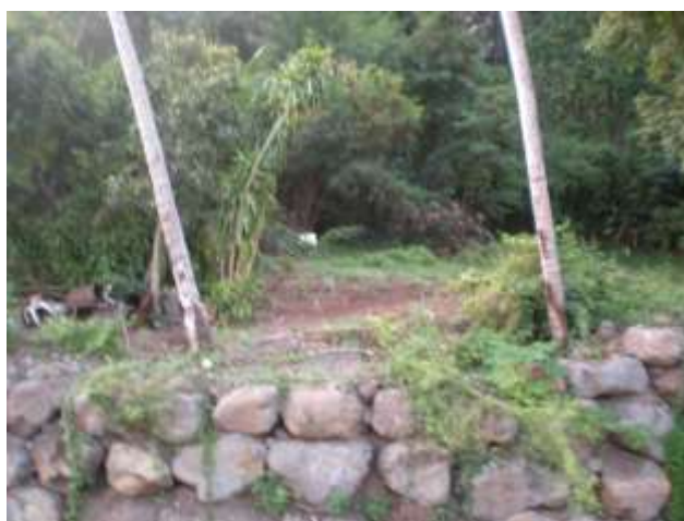
Photo 10 : Protection de berge déstabilisée
