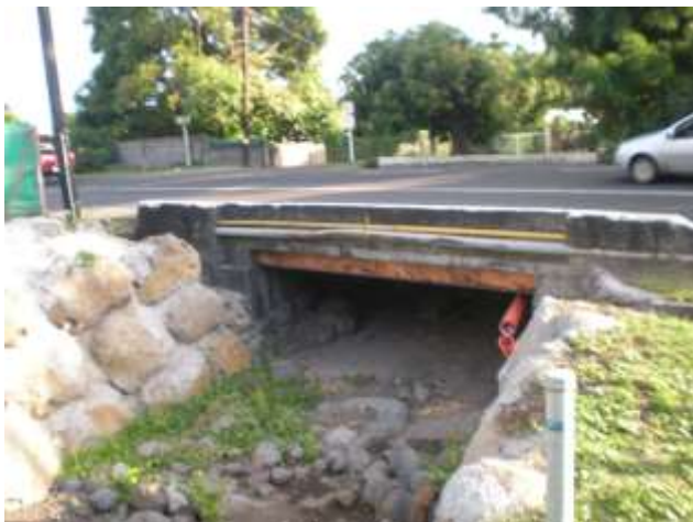
Photo1 : Franchissement de la RT : vue amont
