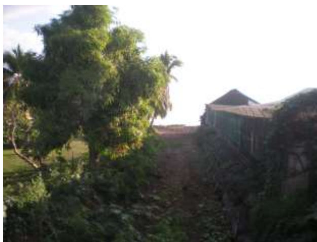
Photo 4 : Protection de berge en rive droite (Chapelle)
