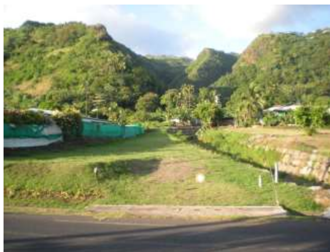
Photo 6 : Risque débordement coude amont RT
