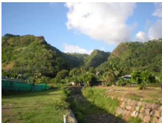
Photo 5 : Vue amont pont RT
