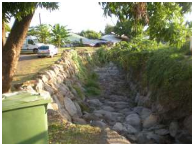
Photo 8 : vue aval franchissement
