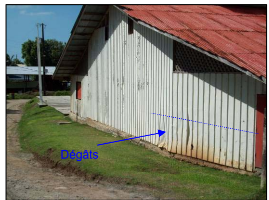
Point de sortie au niveau du coude et dégâts au niveau de la Salle Paroissiale sur le cône actif
