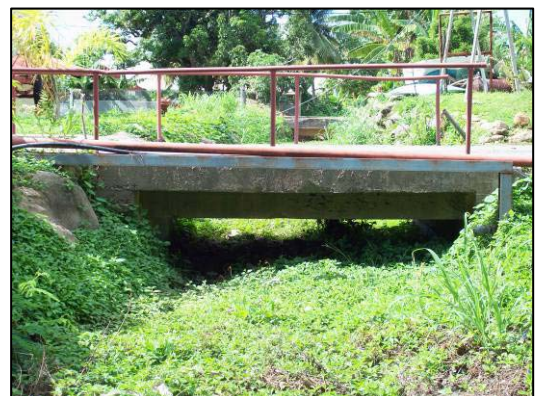
La succession des deux dalots et leur faible tirant d'air
