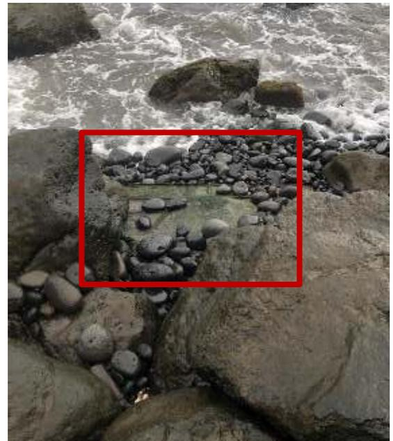
Figure 7 : L'exutoire du dalot C1 est colmaté au pied de la digue. La structure bétonnée est à peine visible.
