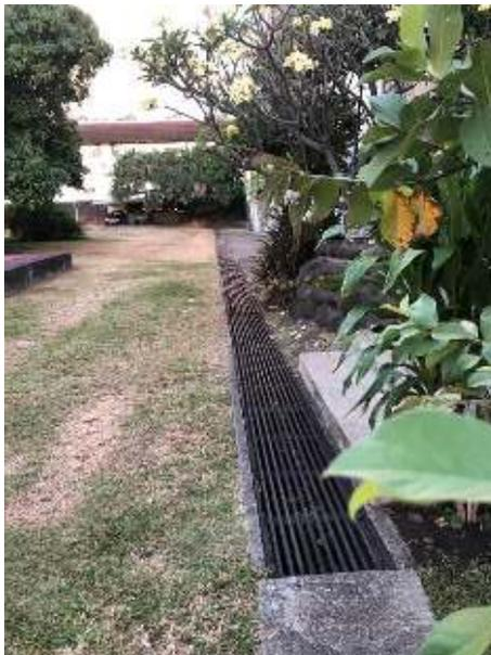
Figure 13 : Le caniveau C4 collecte l'eau des toitures des bâtiments administratifs.
