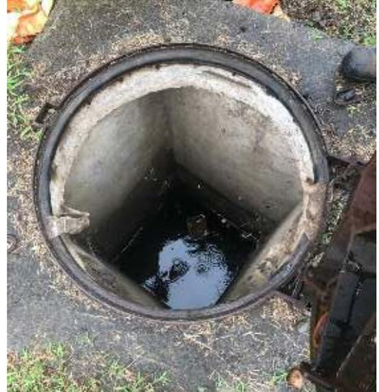
Figure 9 : Comme l'eau ne peut plus s'écouler, elle stagne dans la conduite.
