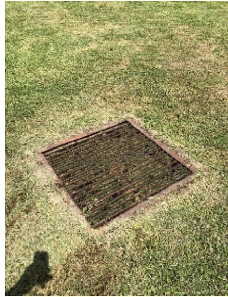
Figure 15 : Grille sur la canalisation C6. Elle est emplie d'eau, aucun n'écoulement n'est perceptible. La canalisation est bouchée.
