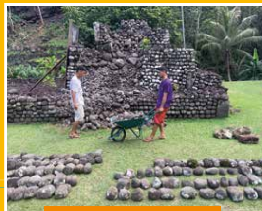
Rangement et triage des pierres effondrées
