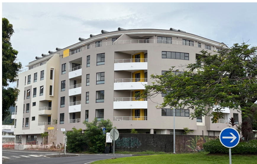
Façade - Avenue Général de Gaulle crédit photo DHV
