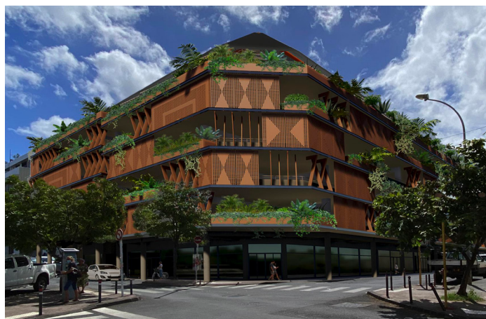
Résidence Te Aho Rua crédit photo Tahiti Nui Habitat
