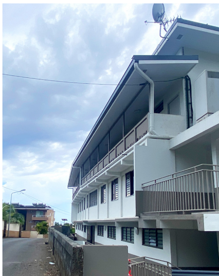
Après réhabilitation crédit photo DHV
