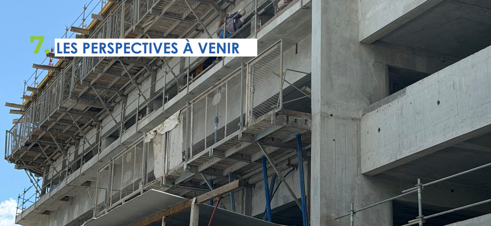
Chantier de la résidence Te Aho Rua - crédit photo DHV
