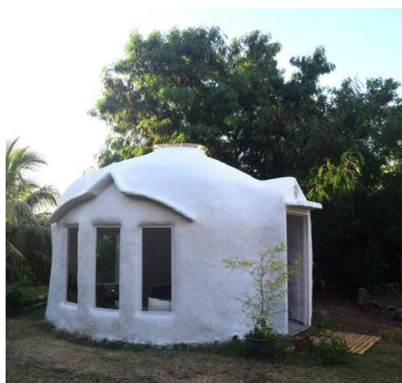
Cocodôme, prototype à base de fibres de coco et de chaux - Crédit photo : Stéphane Sayeb
