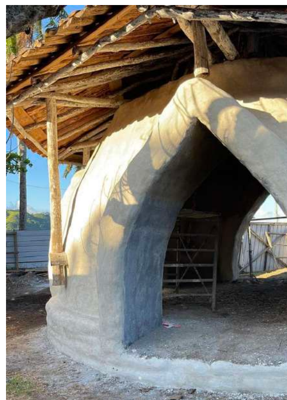
Construction d'un abri en terre à Mataiea Crédit photo : Objectif Terre
