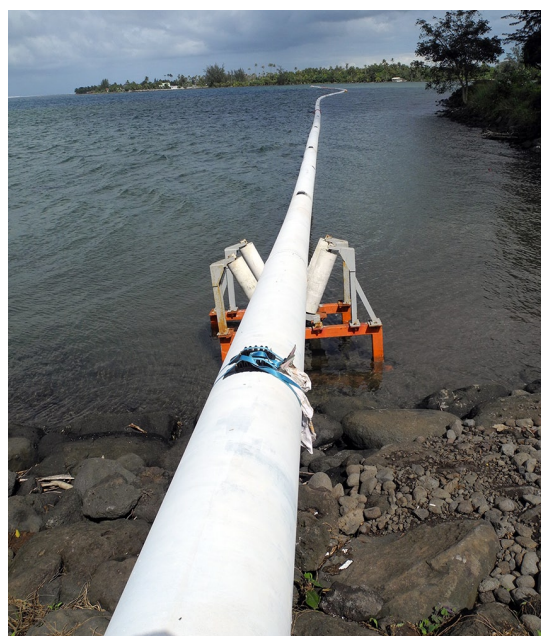
Canalisation SWAC de Tetiaroa en construction à Papeari.
