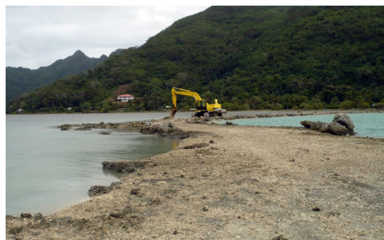
Extraction de matériaux coralliens à Raiatea.
