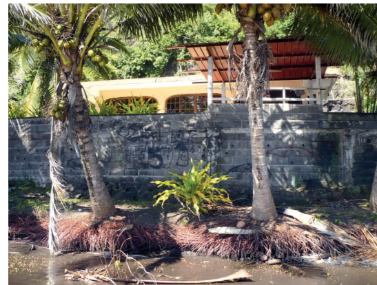
Érosion du bord de mer
