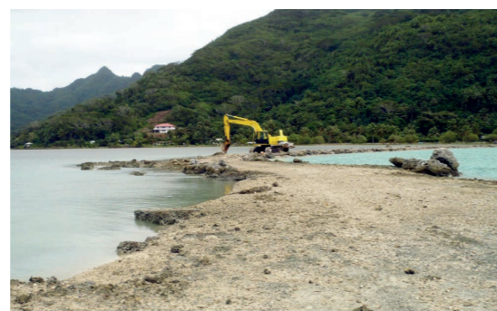
Extraction de matériaux coralliens à Raiatea.
