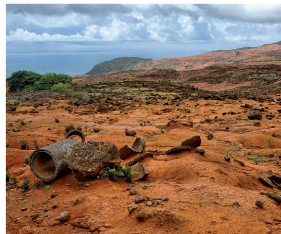
Buses de l'ancienne piste de 1973 mises à nu par l'érosion ici en 2010, île de Eiao (Marquises)
