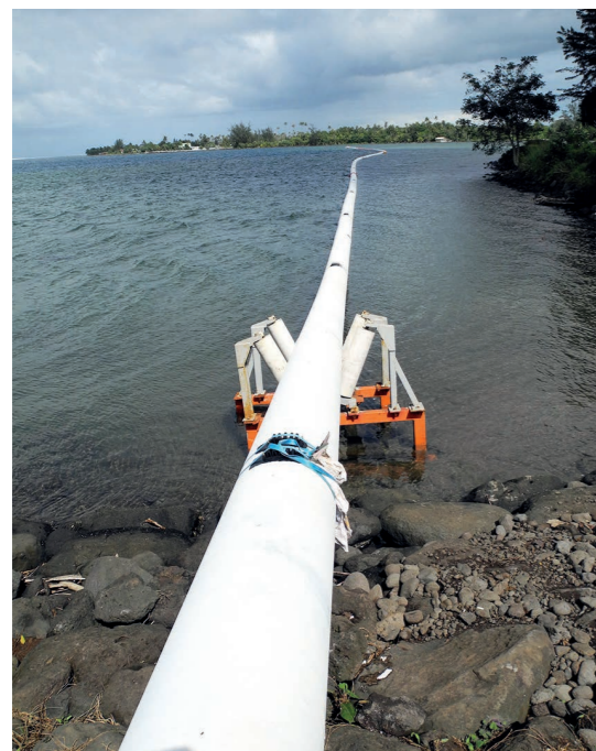
Canalisation SWAC de Tetiaroa en construction à Papeari.
