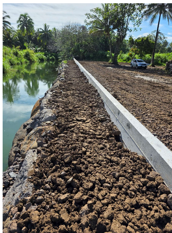
Réfection de l'assainissement pluvial à Teahupoo et aménagement d'enrochement sur rivière © DEQ
