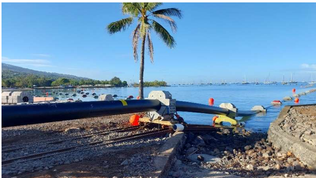
Assemblage des 4 tronçons de l’émissaire avant leur pose à Taapuna (septembre 2025) © DIREN
