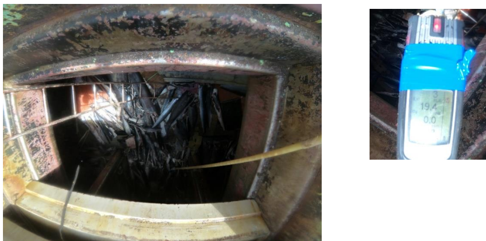
Fig 24 : Ouverture des frigos et contrôle au détecteur de gaz
