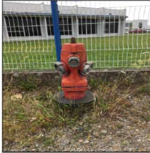
Poteau incendie de 150 mm avec deux sorties 100 mm et une sortie de 65 mm
