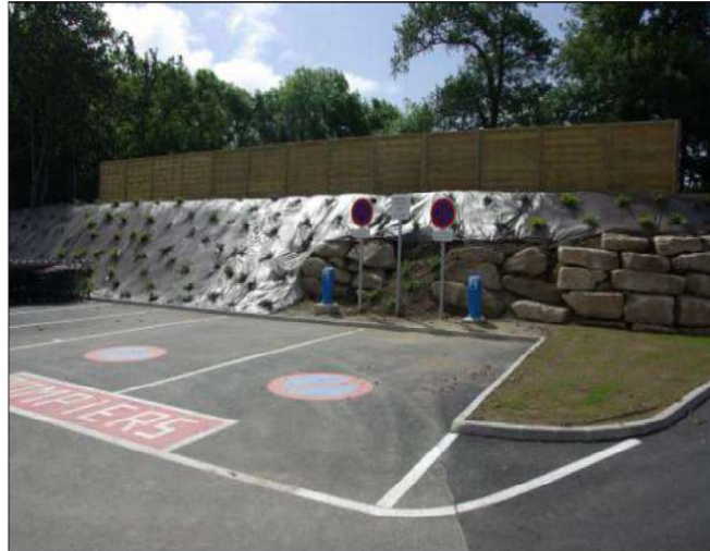
Réserve d'eau enterrée avec 2 poteaux d'aspiration
