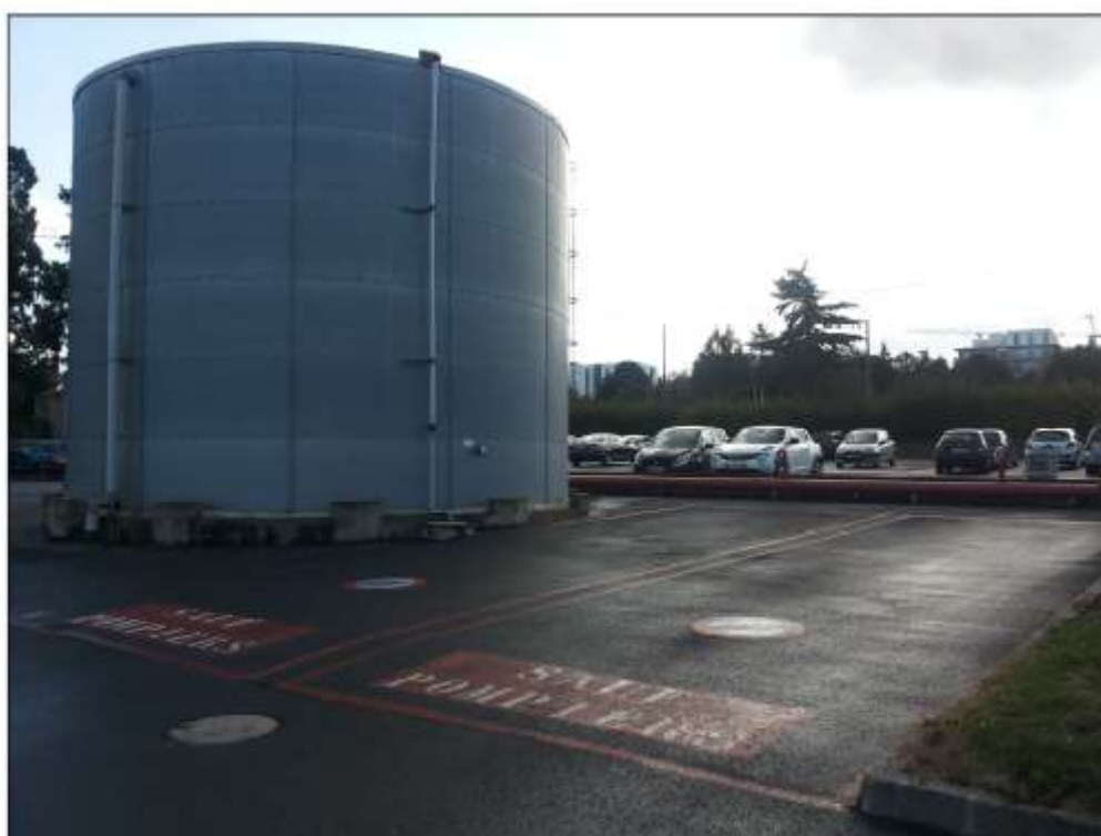
Réserve d'eau incendie aérienne équipée de 2 sorties de 100 mm déportées
