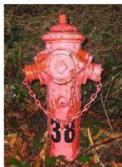
Poteau incendie de 80 mm avec une sortie de 65 mm et deux sorties de 40 mm
