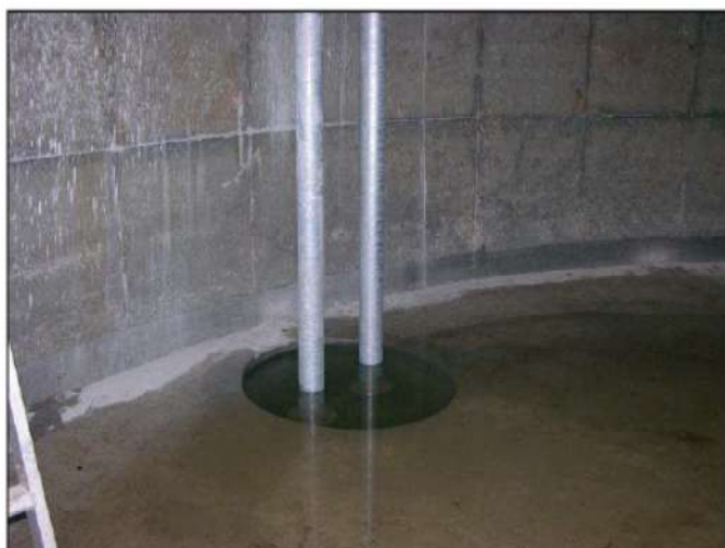
Fond de la cuve avec crépine sous le niveau sur le plus bas de l'eau
