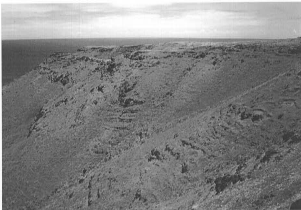
Fig. 14 : Chenaux d'écoulement sur les versants ouest de la basse vallée de Manihina. Les niveaux de roches affleurantes ainsi que la faible épaisseur du sol sont apparents.
