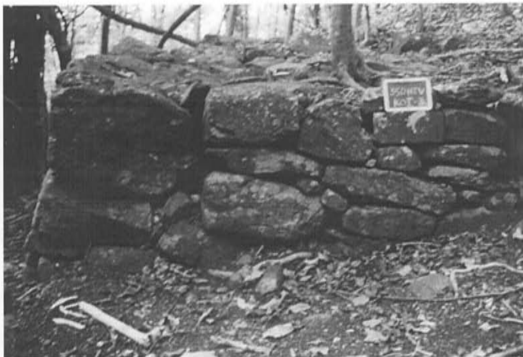
Fig. 110 : Structure 3 vue de profil (depuis le nord).
