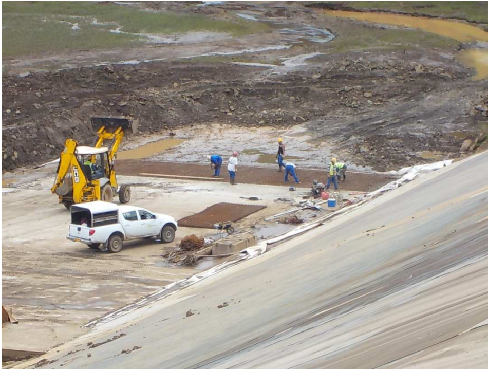
Coulage de la dalle de pied d'ouvrage
