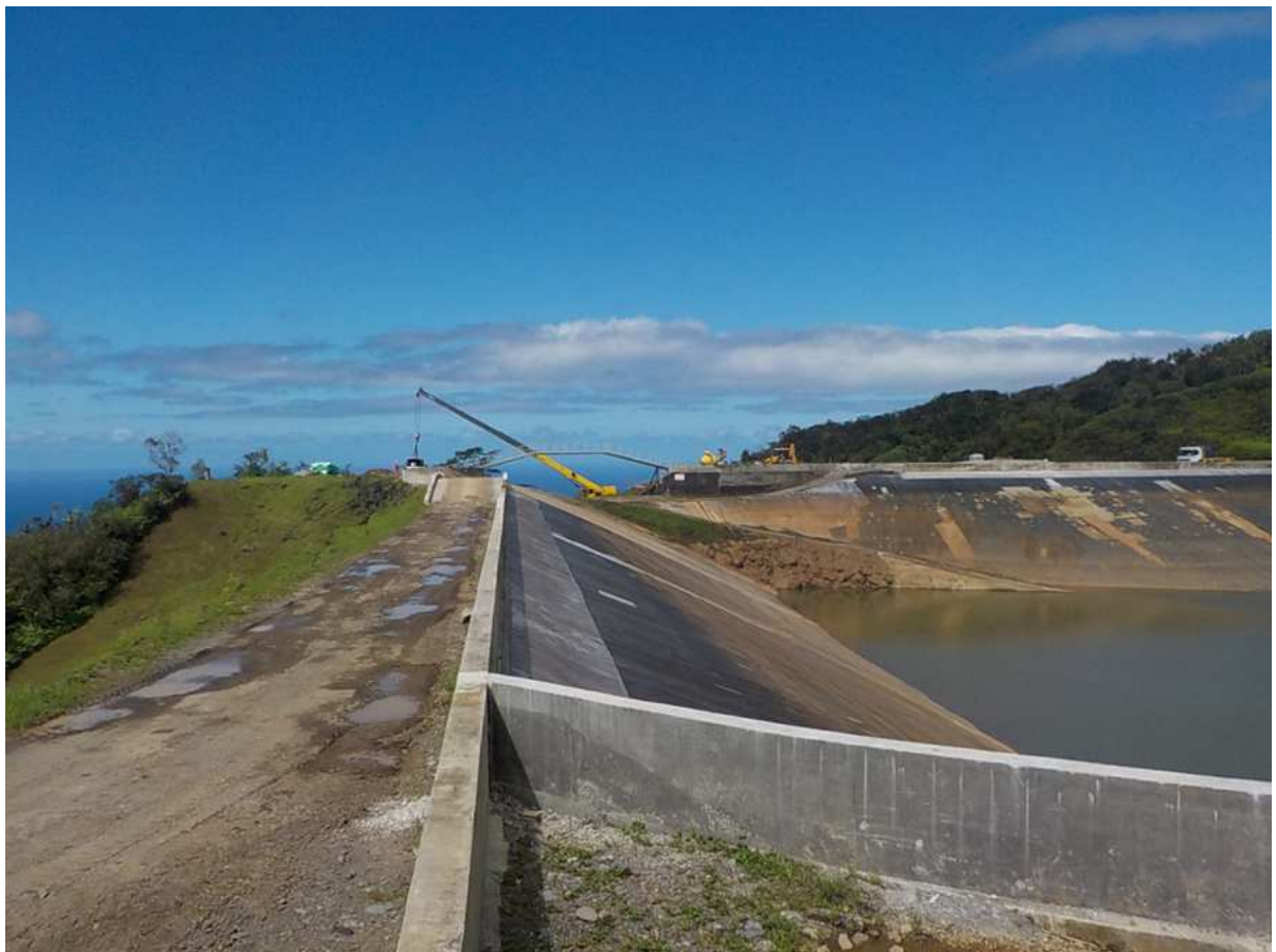
Vue du barrage de Faatautia AB depuis la digue B
