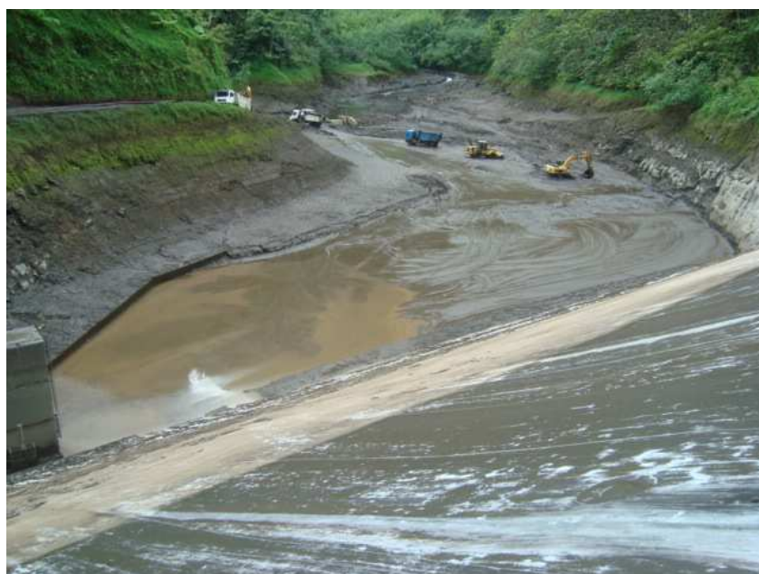
Curage du barrage de Vaite 2
