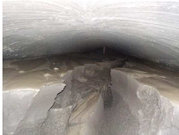
Vue intérieure du dégraveur Vaitamanu bouché
