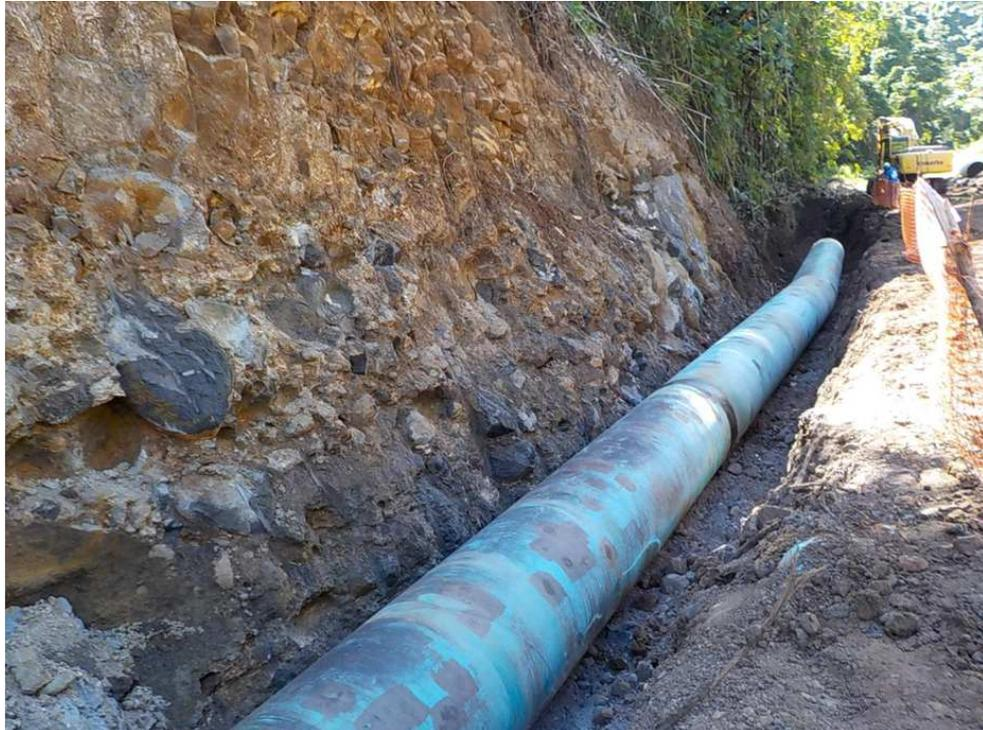
Mise en place de la conduite forcée Hydromax Titaaviri
