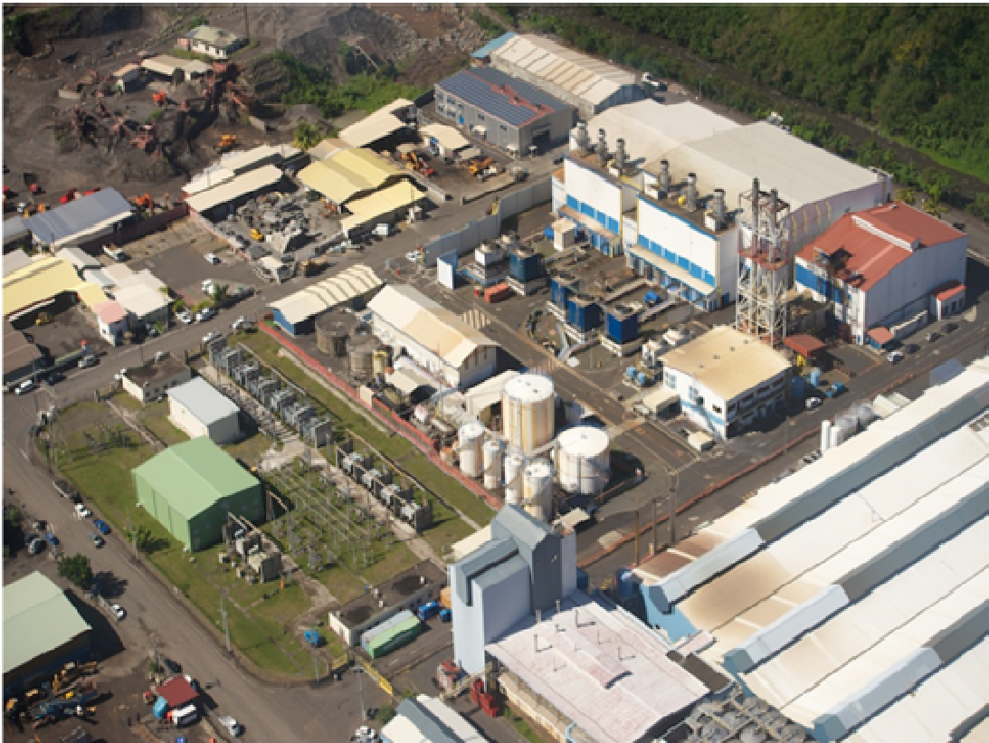
Centrale thermique de la Punaruu
