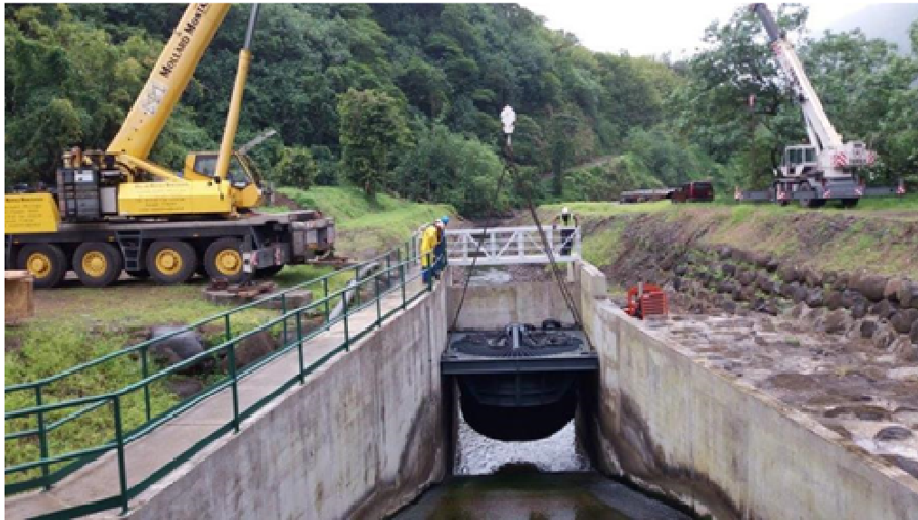
Mise en place turbine
