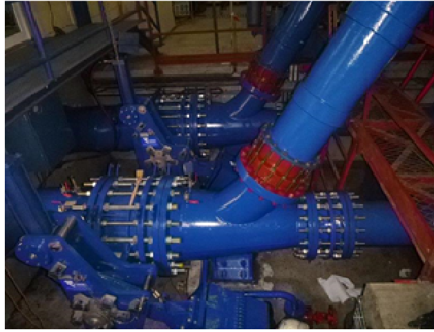
Nouvelles vannes en place
