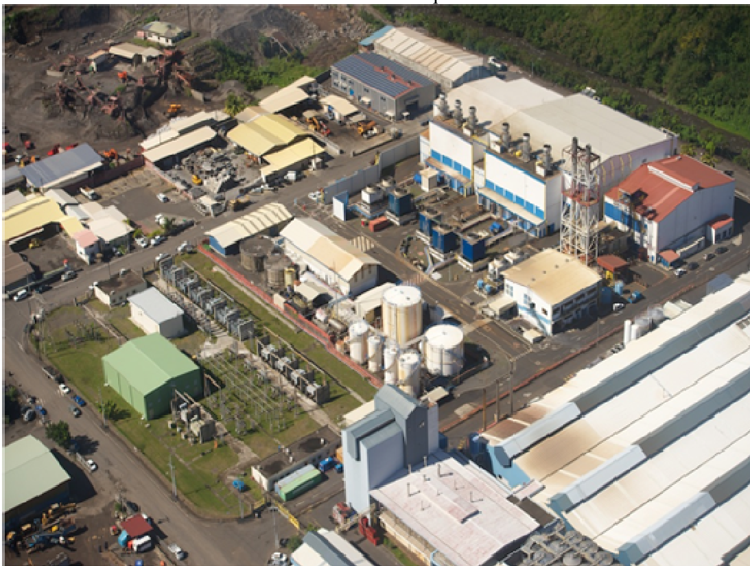
Centrale thermique de la Punaruu
