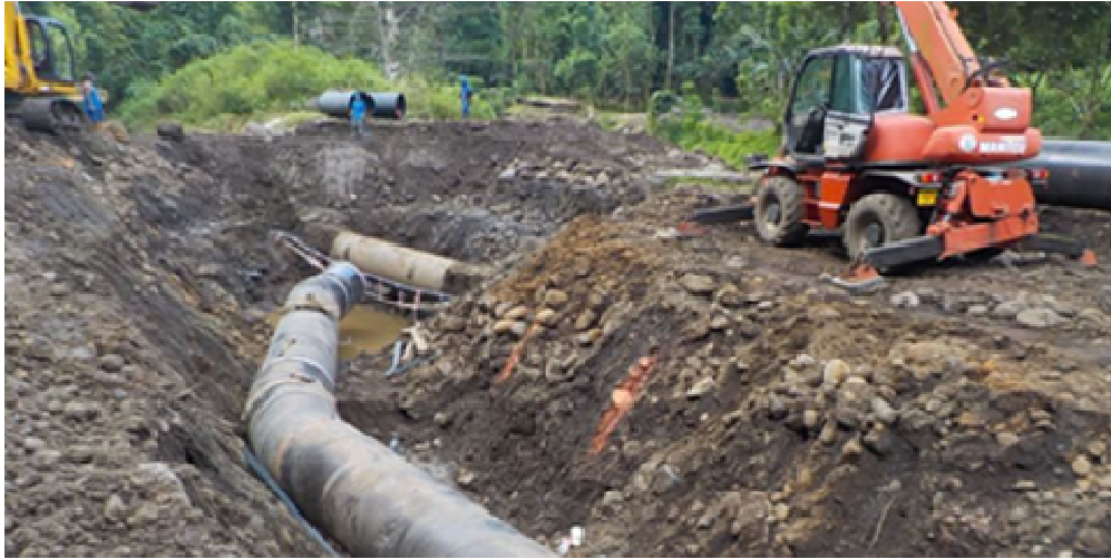
Raccordement des 2 conduites
