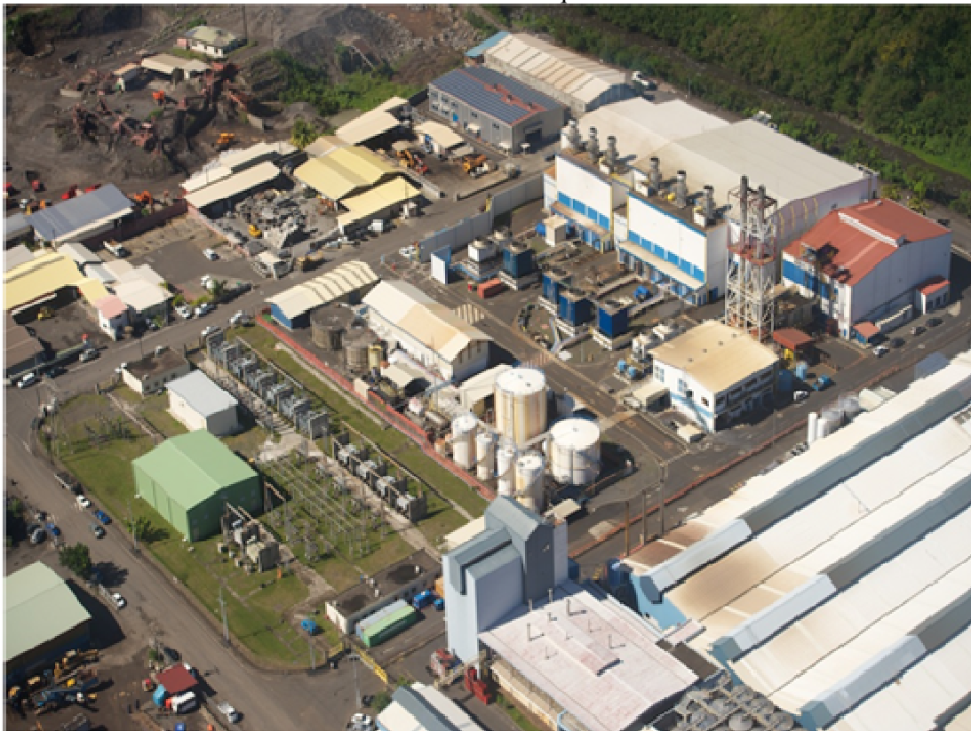
Centrale thermique de la Punaruu
