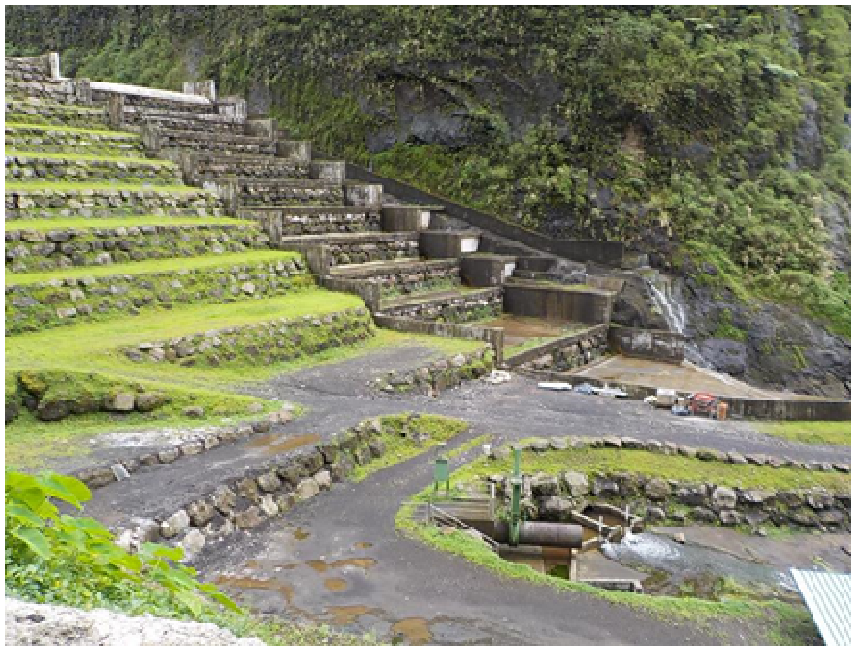
Vue du barrage de Titaaviri 2 depuis l'aval
