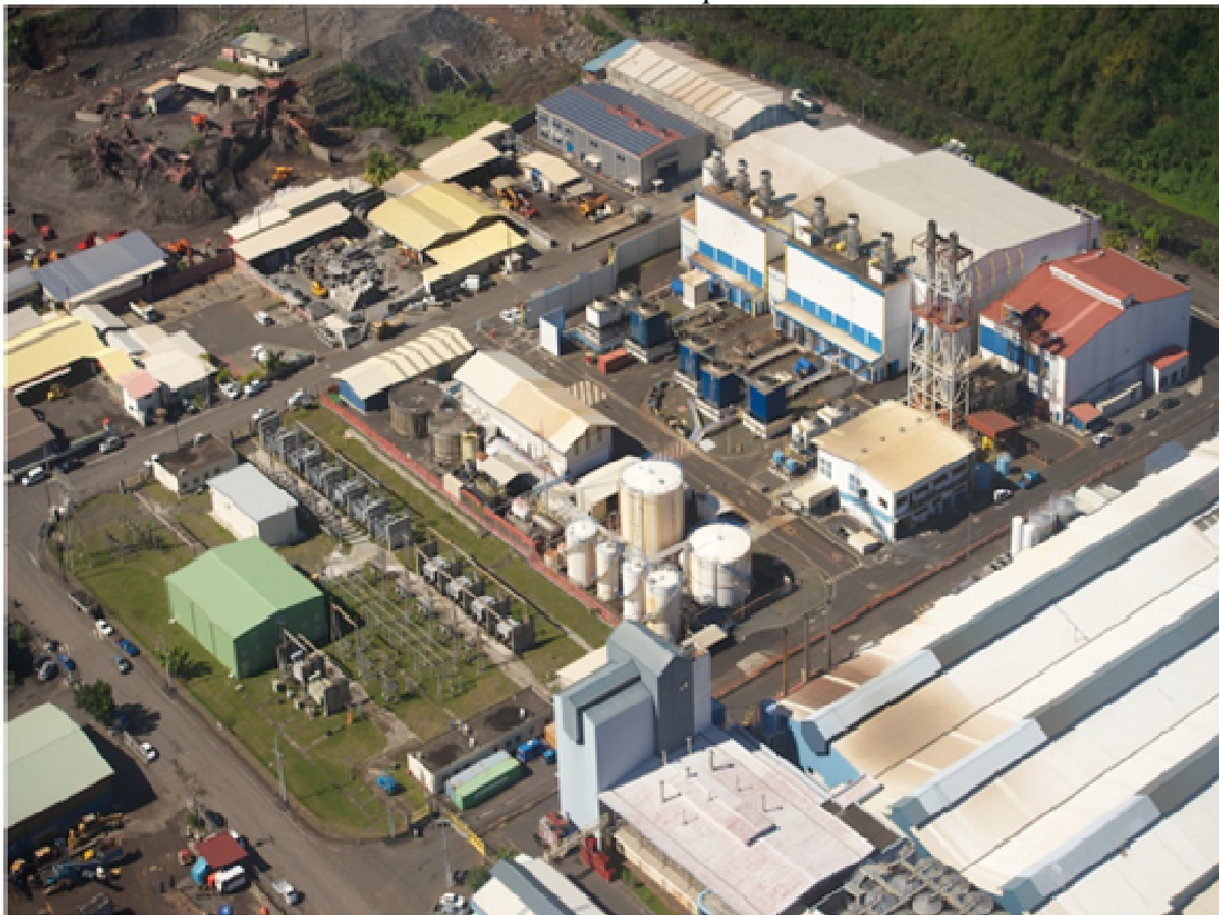
Centrale thermique de la Punaruu
