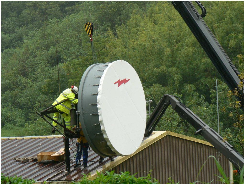
Opération d'échange du Faisceau Hertzien coté Papenoo
