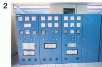
Armoires d'automatismes
