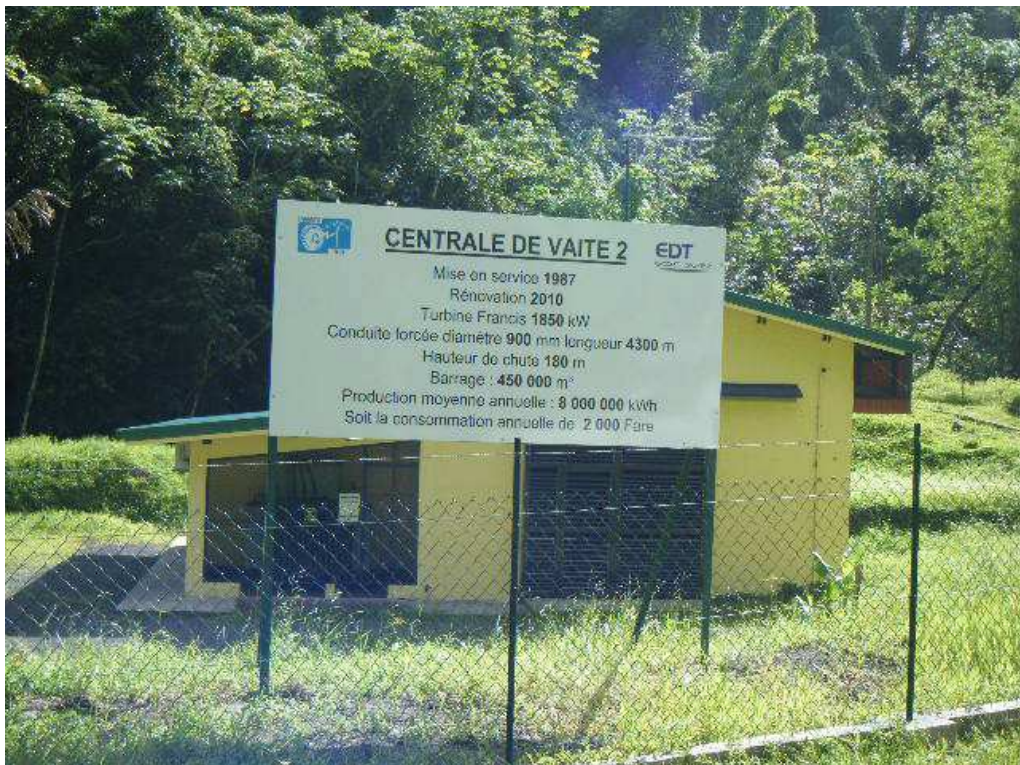
Vue ext rieure de la centrale de Vaite 2 r nov e
