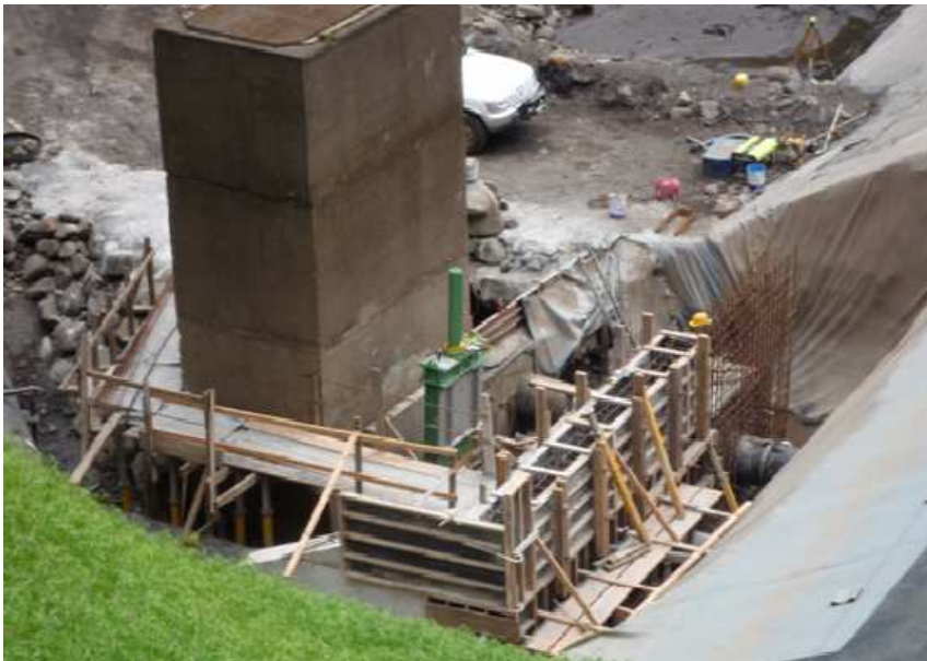
Modification de la tour de prise
