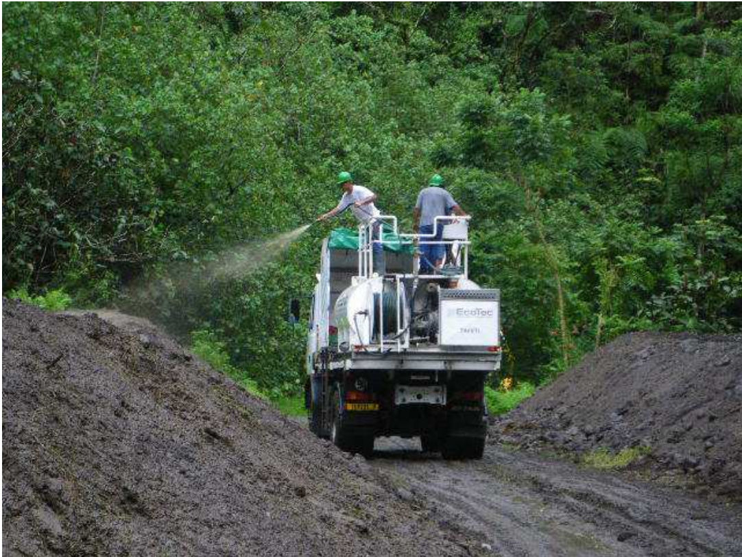
Opération de re-végétalisation de casiers de curage
