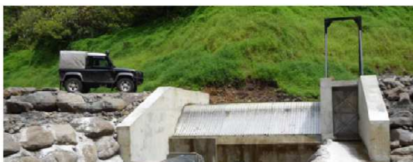
Captage amont et grille Coanda en service
