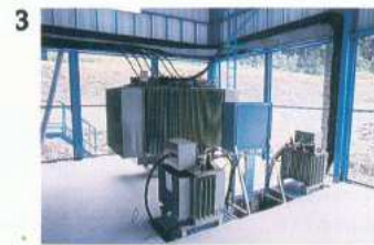
Poste de transformation
