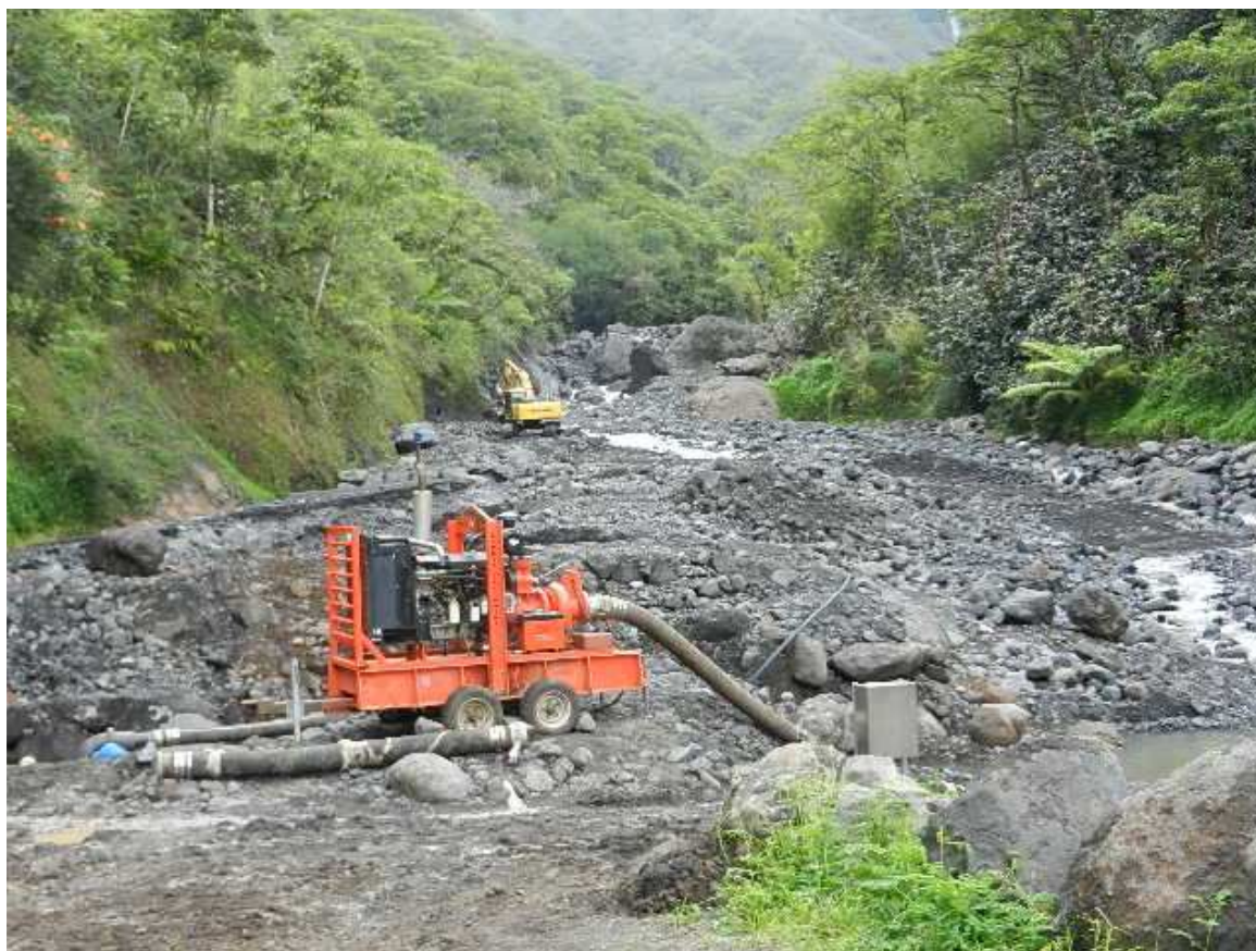
Photo de la zone du captage complètement submergée sous une rivière de sable (au premier plan une pompe de débouchage de la conduite forcée)
