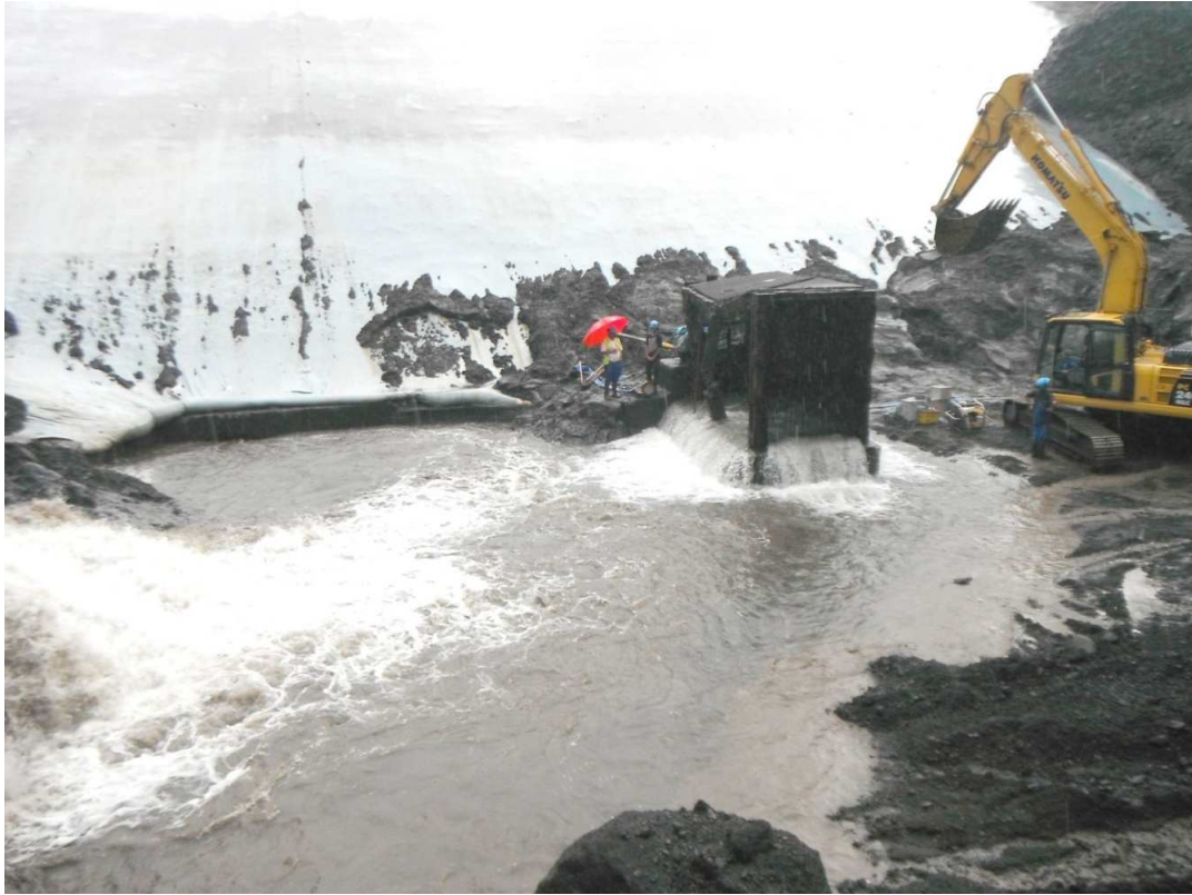
Grille du bassin de Vainavenave collapsée
