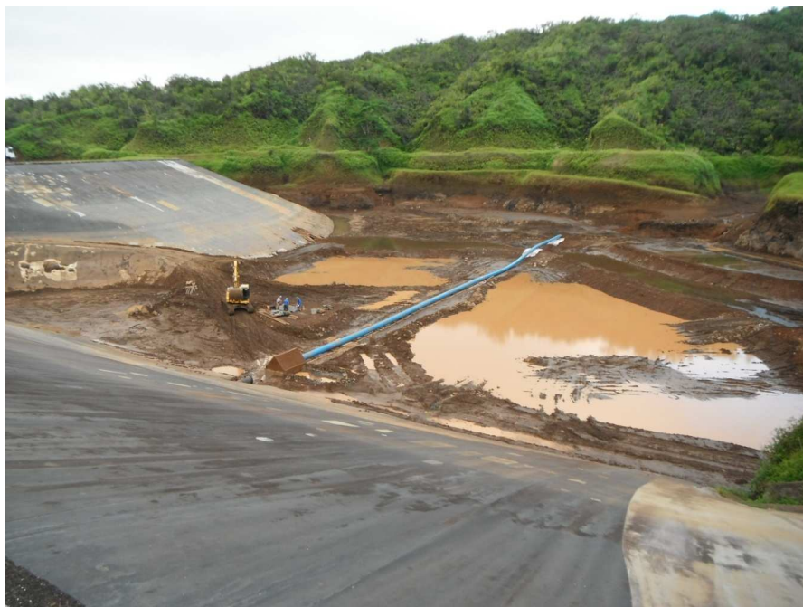
Tube PEHD DN 600 de 98 m de long en cours d'introduction dans la vidange
