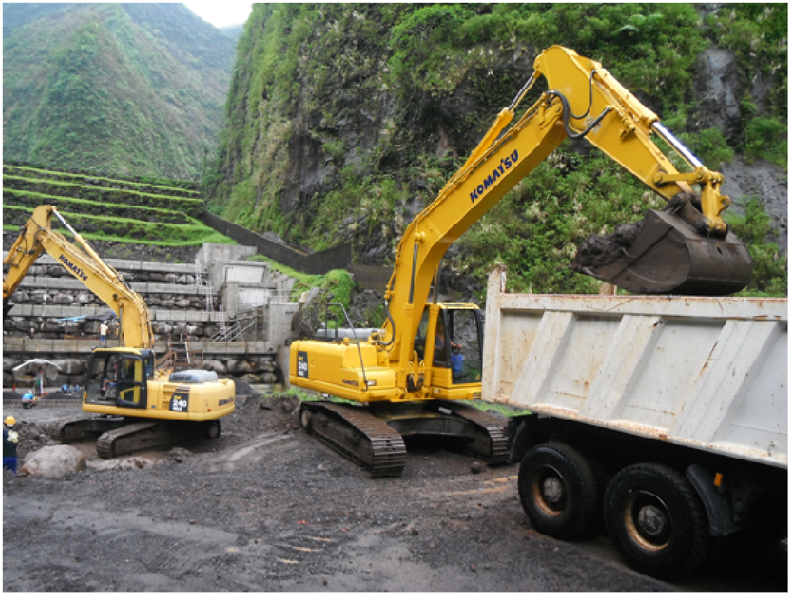
Vue du barrage de Titaaviri 2 vers l'amont
