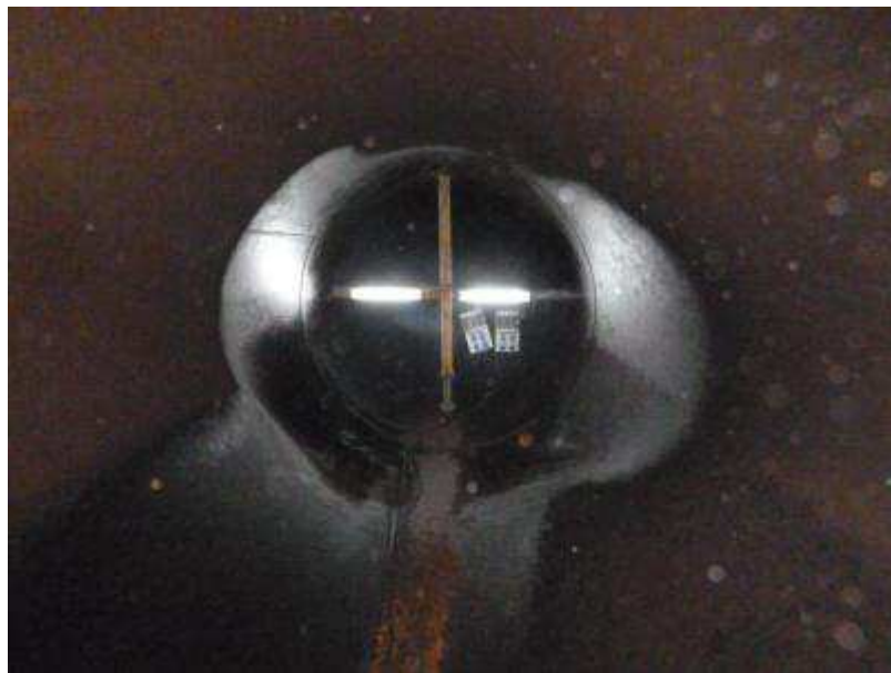
Chantier de soudage par l'intérieur de la conduite Papenoo 1
