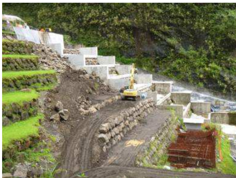
Travaux de recharge aval et du déversoir de Titaaviri 2
