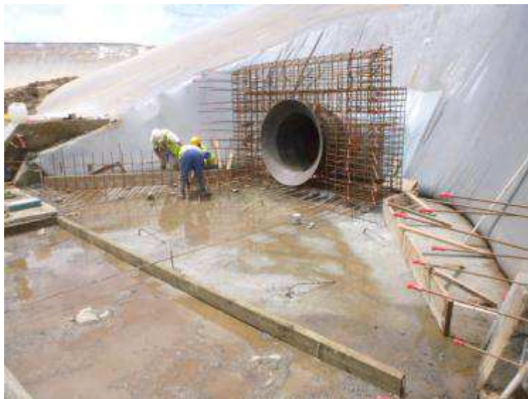
Nouvelle plinthe de Faatautia AB – Digue A au droit de l'entonnement de la vidange
