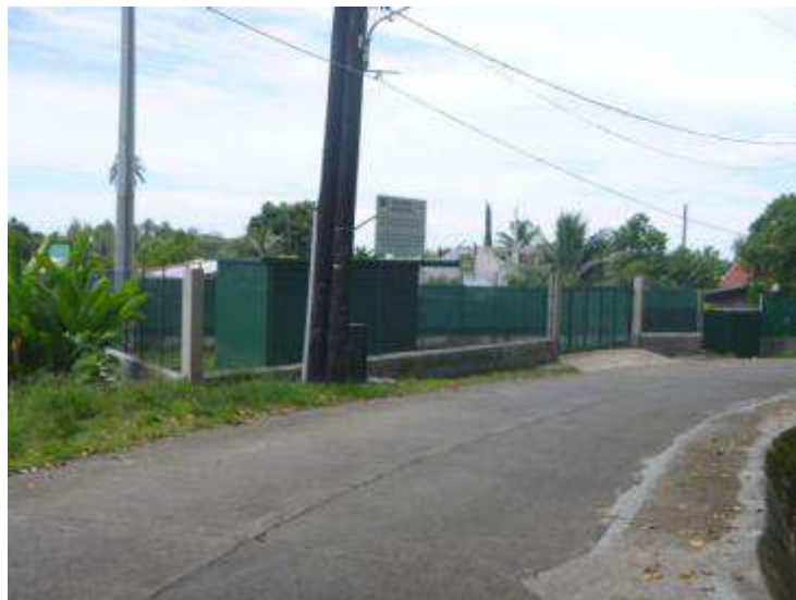
L'enclos, le local technique et le poteau support d'antenne du FH Vaihiria
