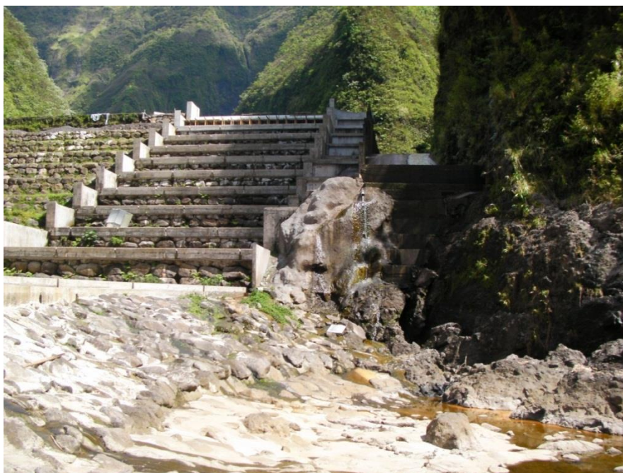
Déversoir de secours de Titaaviri 2
