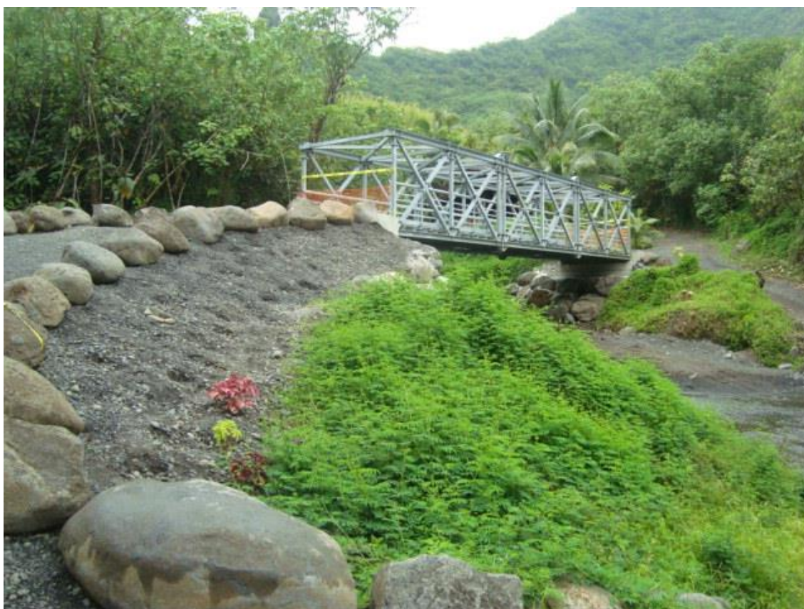
Nouveau pont sur la Vaitapaa
