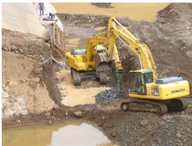
Nouvelle plinthe de Faautia AB – côté digue B
