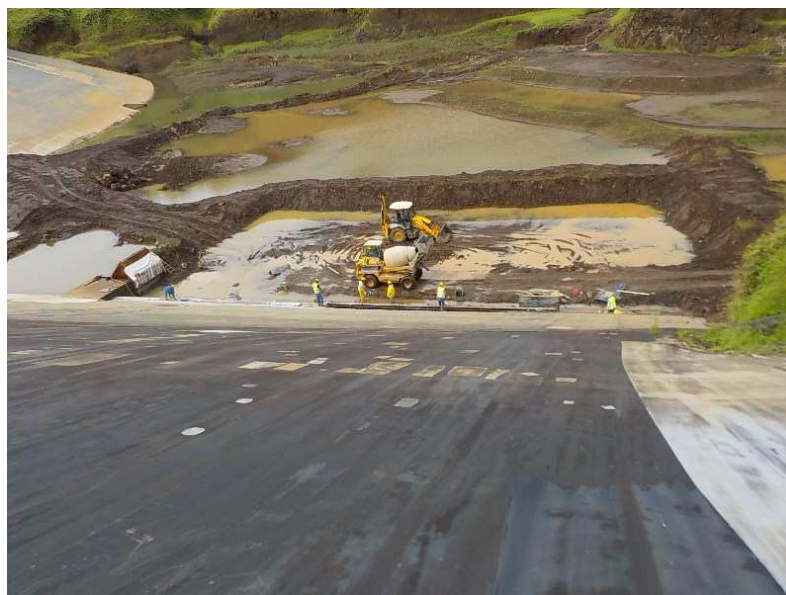
Nouvelle plinthe de Faatautia AB – coté digue B
