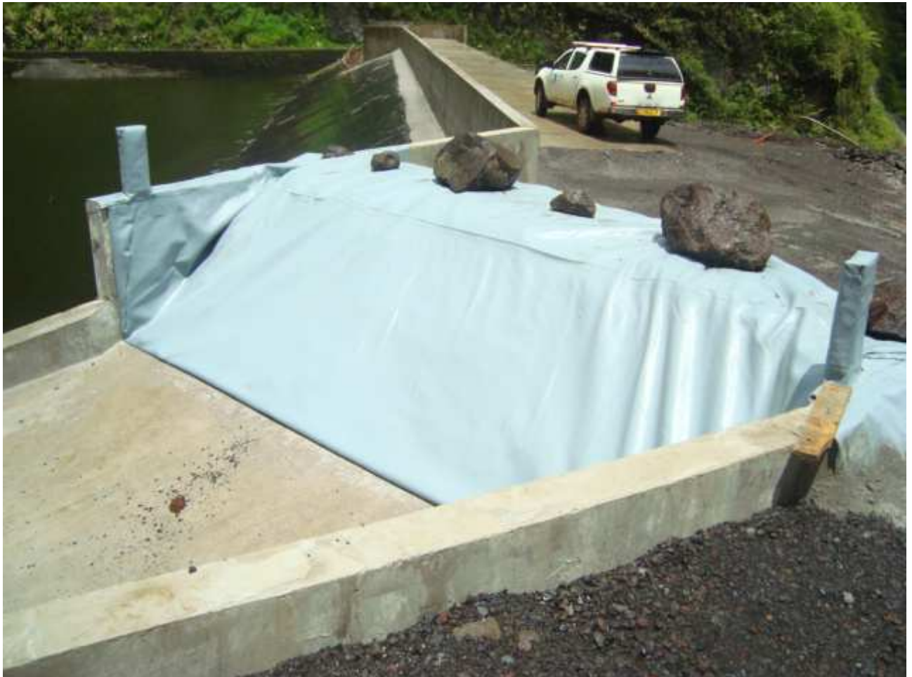
Crête du barrage Titaaviri 2 terminée
