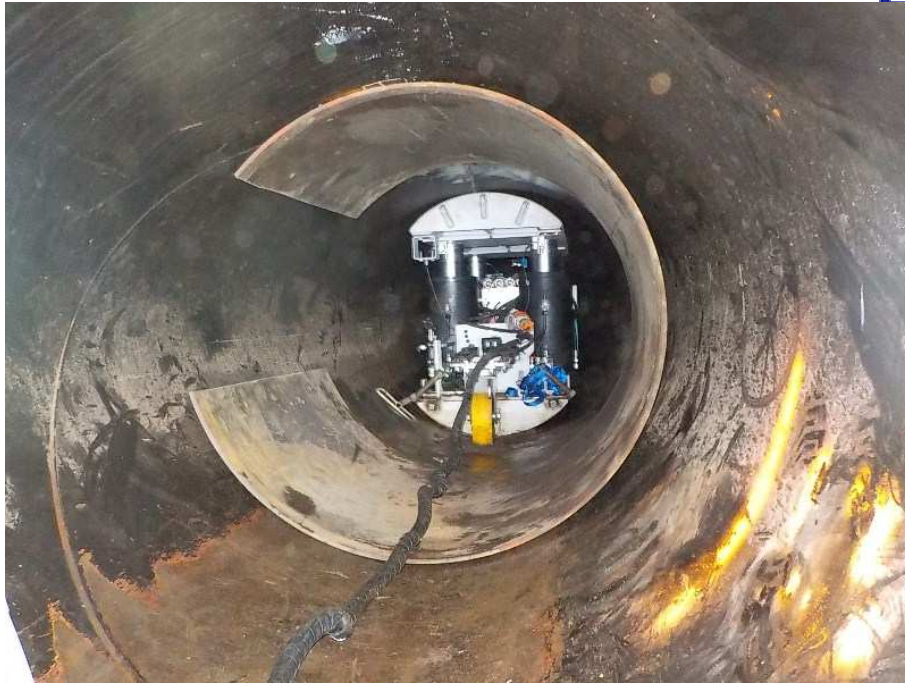
Un manchon (« sleeve ») à poste en attente de soudage, le robot étant lui à l'aval en train de garantir le non écrasement du tube
