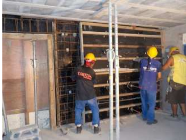
La nouvelle salle de conduite en cours de coulage
