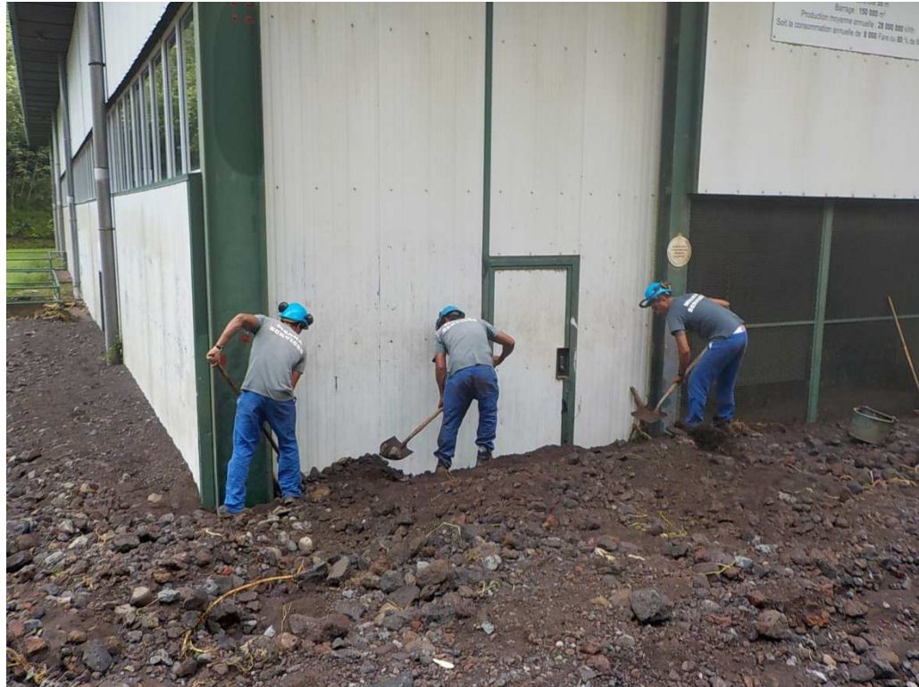
Déblaiement de la centrale Papenoo 0
