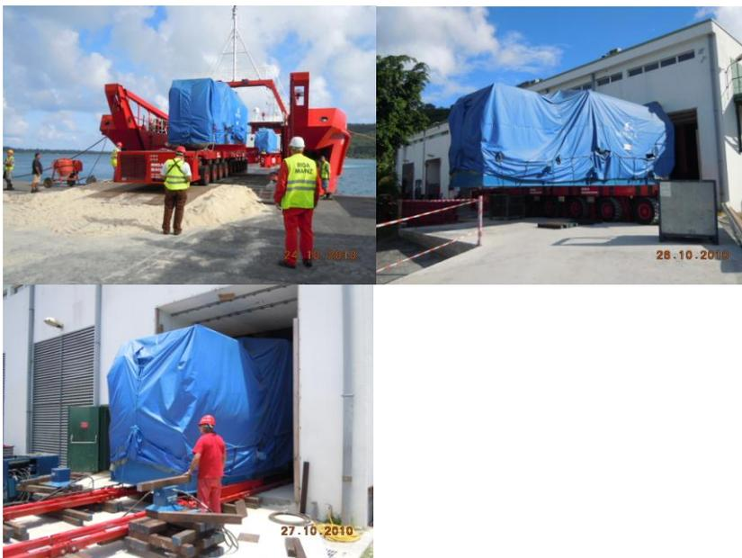
**Transformateur du GE6 :** Remplacement sous garantie par le constructeur du transformateur bloc du groupe G6. Ce transformateur avait subi une avarie après 470 heures de fonctionnement.
