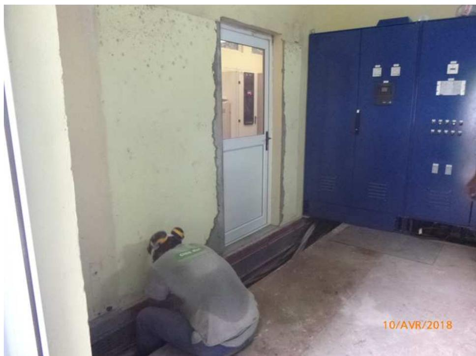
*Armoire automate Faatautia 1A en cours de raccordement*
