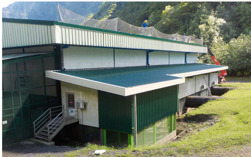
Nouvelle toiture Papenoo 1
