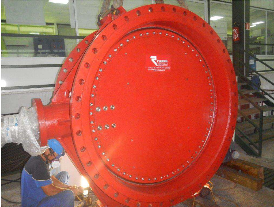
Remplacement vanne de pied Papenoo 0 turbine 1
