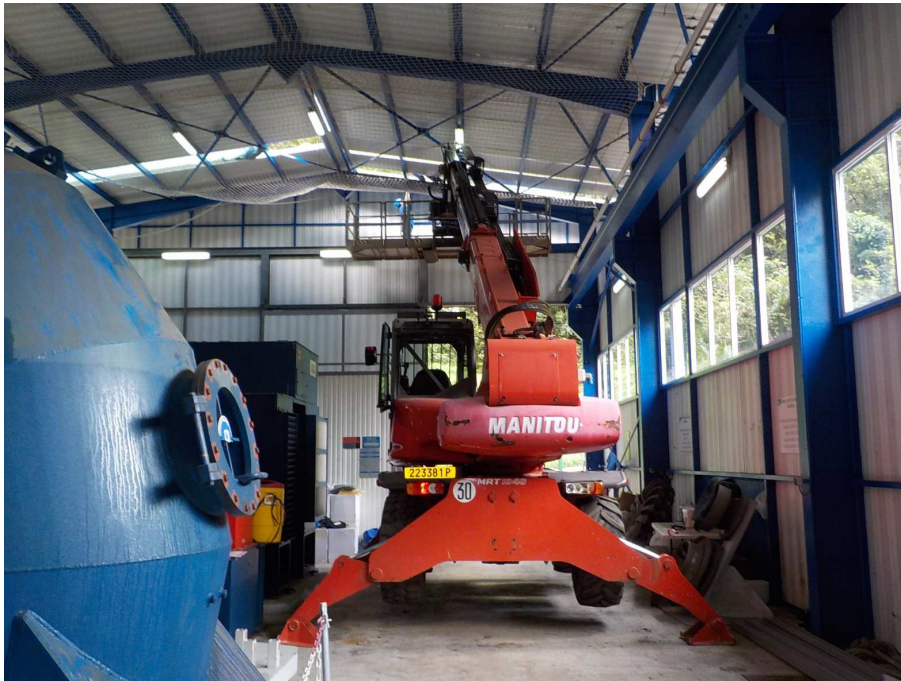
Renouvellement de la toiture Papenoo 0
