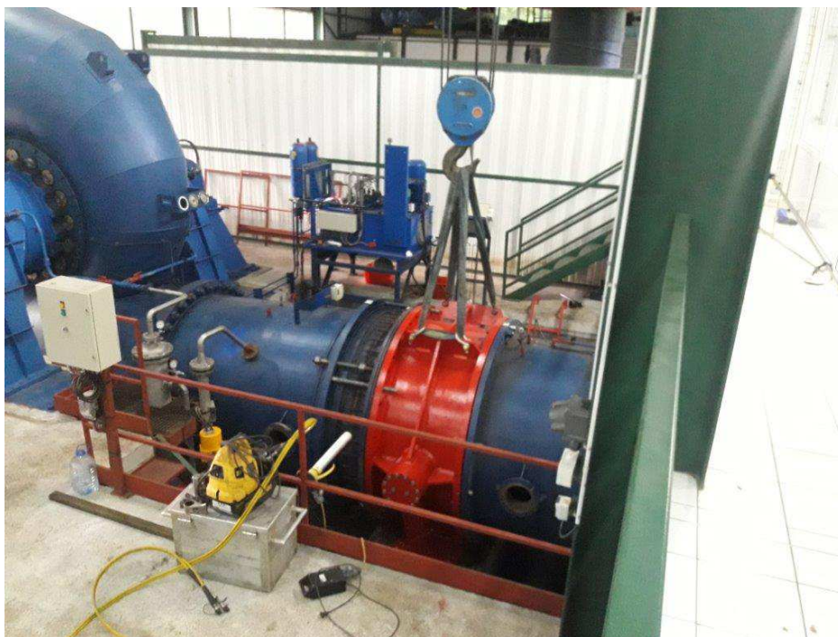
Remplacement vanne de pied Papenoo 0 turbine 1
