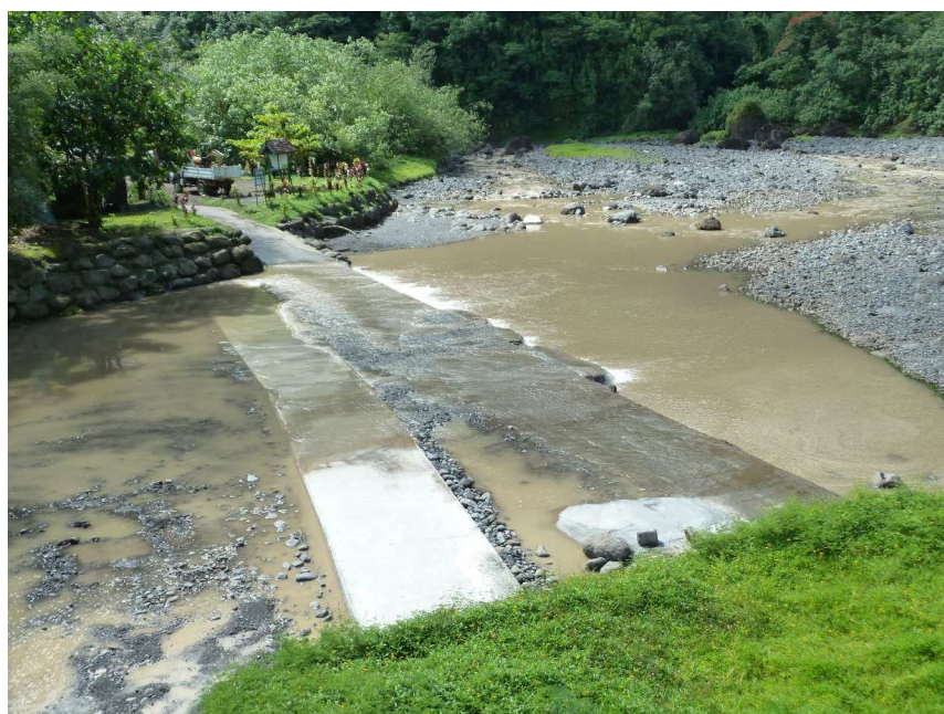
Carapace de la protection de la conduite Papenoo 0 terminée à Cote 45
