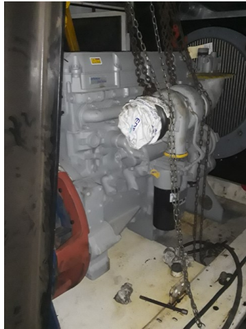
Bloc moteur du GE1 neuf posé dans le capotage
