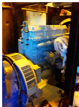
Photo du bloc moteur neuf du G6 posé
