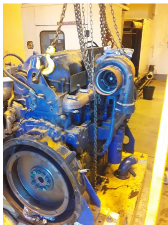
Photo du bloc moteur du GE3 déposé
