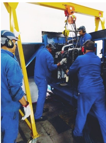
Pose nouveau bloc moteur du GE2
