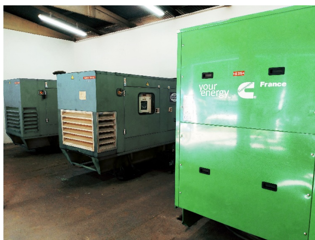
Groupe CUMMINS C250 en lieu et place du GE3 FG Wilson
