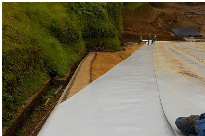
Pose de la dernière lé de liner sur Digue A
