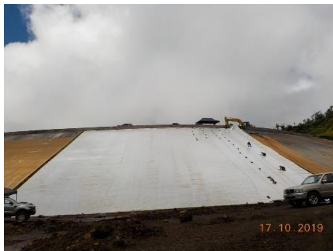
Remplacement du liner Digue A Bassin AB
