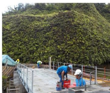
Pose du nouveau pont
