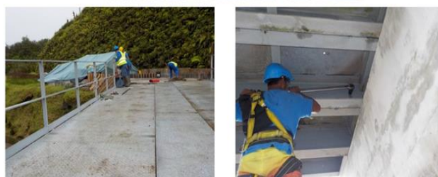
Nouveau pont en place en cours de finition
