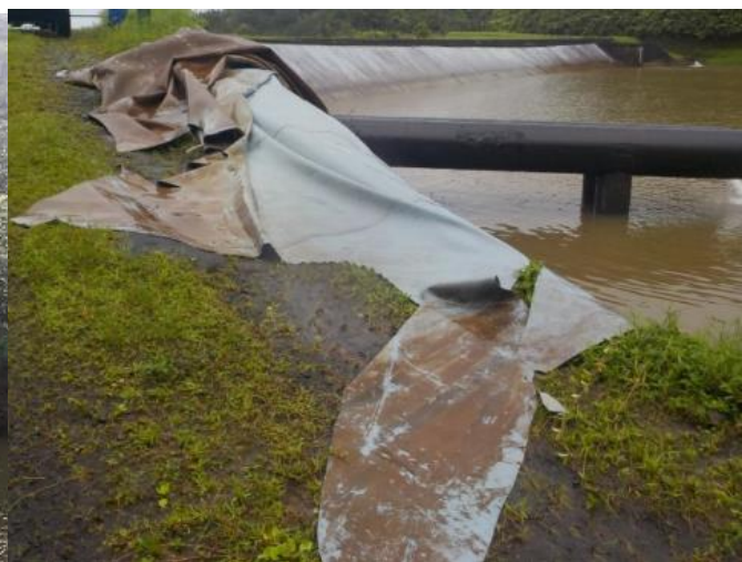
Protection liner rive gauche
