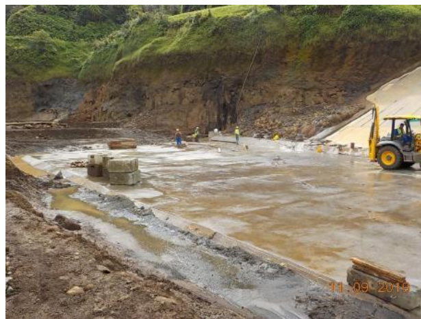
Béton coulé sur la dernière zone Bassin AB
