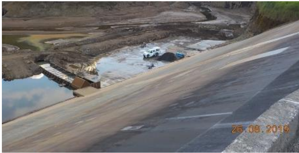
Dernière zone de coulage de béton préparée Bassin AB
