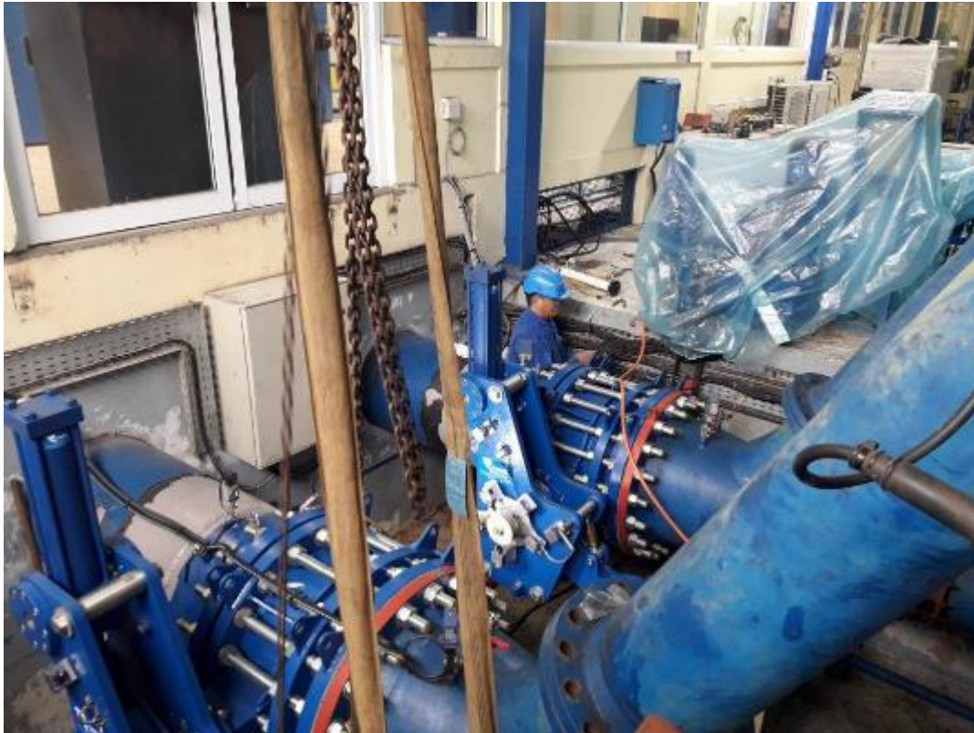
Remplacement des Vannes de Pied P2T1 et P2T2
