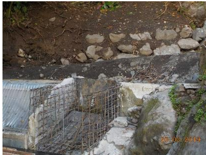
Captage G1 en cours de réhabilitation
