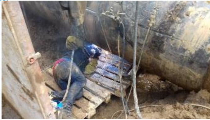
Conduite en réparation
