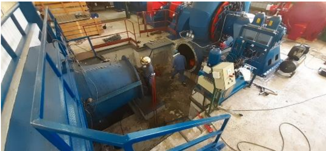
Remplacement de la Vanne de Pied P1T2
