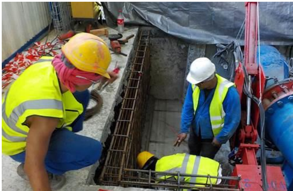
Ferrailage Génie Civil Vanne de Pied Centrale P2
