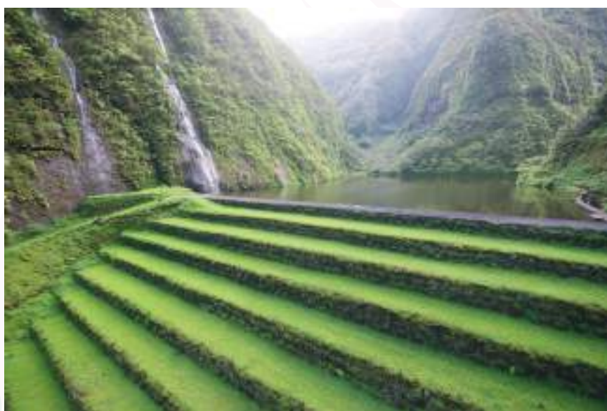
Installation hydroélectrique de la Titaaviri
